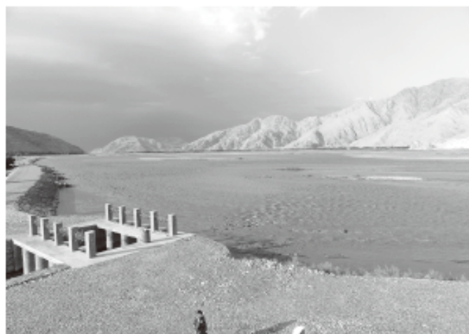
建設中のミラーン取水口（2015年7月）
