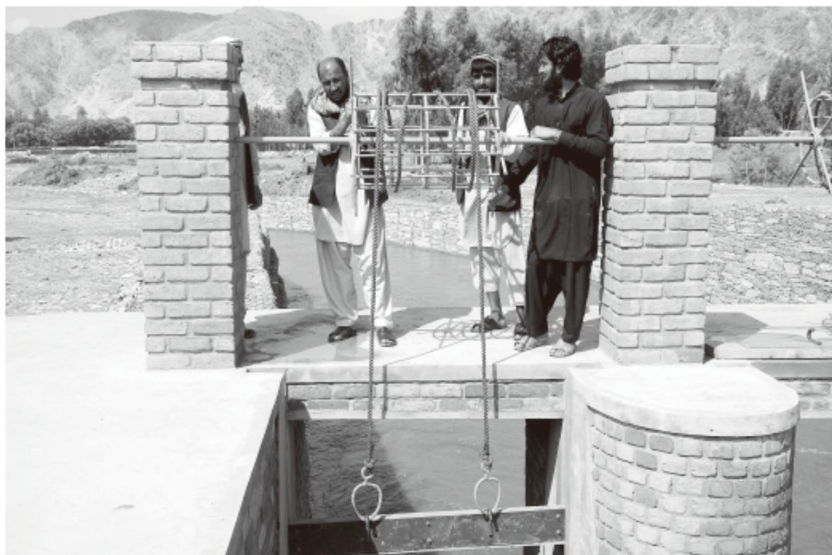
堰板方式取水門。堰板の上げ下ろしを指導するエンジニアのファヒーム（左）
