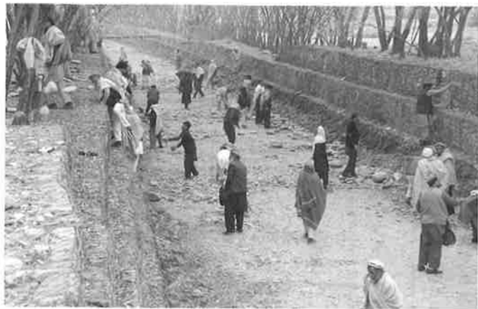
堰の改修中に用水路内の掃除を地域住民が行う。カマ第一用水路(2017年12月26日)
