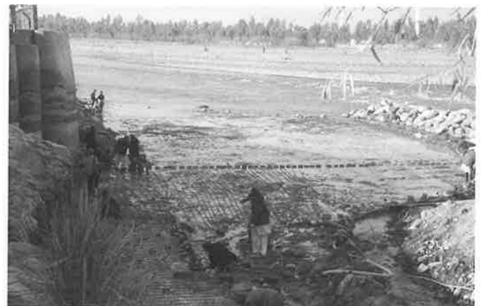
昨年11月から開始したカマ堰改修事業の土砂吐部の工事。写真左は2011年完成したカマ第II取水門(2017年12月19日)
