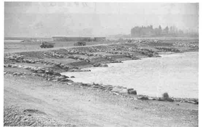
クナル河に設置された石出し水制群(マルワリードII堰から約4~5km周辺護岸工事。2018年3月1日)
