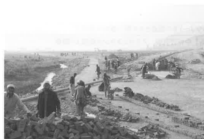
用水路工事では、帰還難民の作業員も多い(2018年1月24日)
