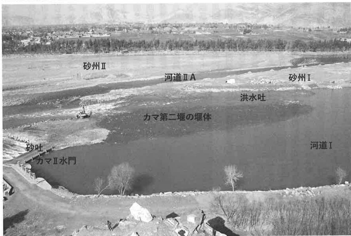
カマ第二堰。堰の越流水と、砂吐、洪水吐からの流れ及び河道II Aの流れは下流の中央で合流する。山田堰とそっくりである(2018年2月21日)
