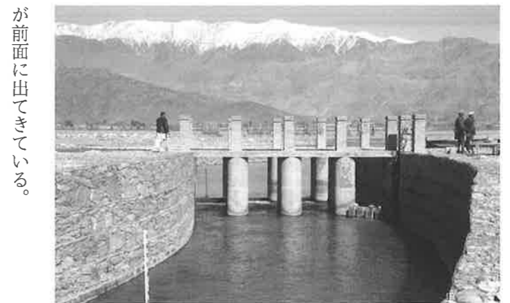
マルワリードII取水門から見るケシュマンド山脈。積雪が少ない(2018年2月18日)
