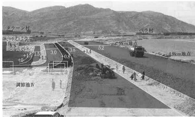
巨石や砂利で造成中の洪水流入地点の強化堤防（陸側へ4段）と調節池Ⅳの造成（2018年4月25日）
