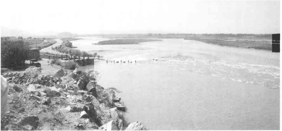
[上] マルワリードⅡ堰。造作後2年を経て、ほとんど目立った変化が見られない。本堰は地理条件にも恵まれて、最も安定した堰である。岩盤下流側は著しい土砂堆積が問題であったが、水門付近の砂利吐きが奏功している。(2018年9月24日)
