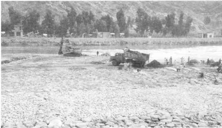
カマ第一堰改修は予定通り進んでいる。今回は砂州との接合部の工夫が主題の一つだ。全体に手際よい作業工程で、作業員は巨礫の取扱い、砂利の活用らに習熟している(2018年10月28日)
