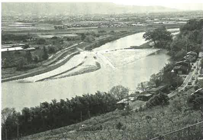
PMS方式取水システムのモデルとなった山田堰（福岡県朝倉市）
