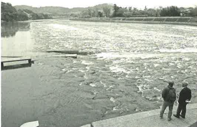
石張り面積25,000㎡の山田堰
