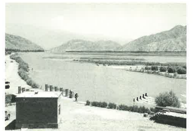
堰幅444mのミラーン堰全景。取水口に向かう河道が安定するよう護岸には多数の石出し水制が施された。砂州上にはヤナギによる粗朶(そだ) 柵工が見られる。(2017年6月14日)
