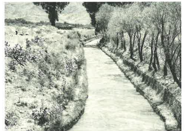
マルワリード用水路を取水門から眺める。用水路床を改修したことにより、流速が増した(2019年6月18日)
