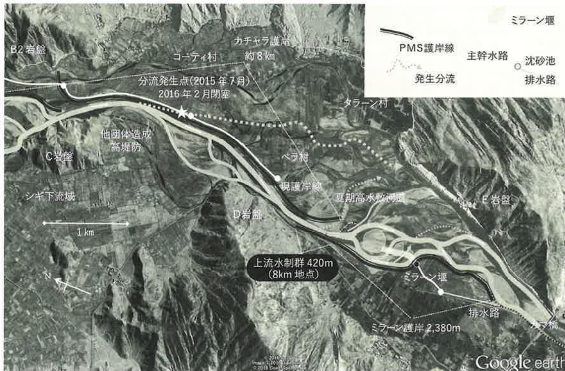
クナル河・ミラーン堰周辺河道と護岸工事
