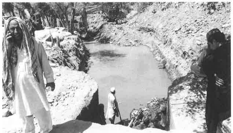
土砂かき出し作業中。マルワリード用水路N地区サイフォン（40m）出口から用水路付近。写真左はファヒーム技師（2020年8月5日）
