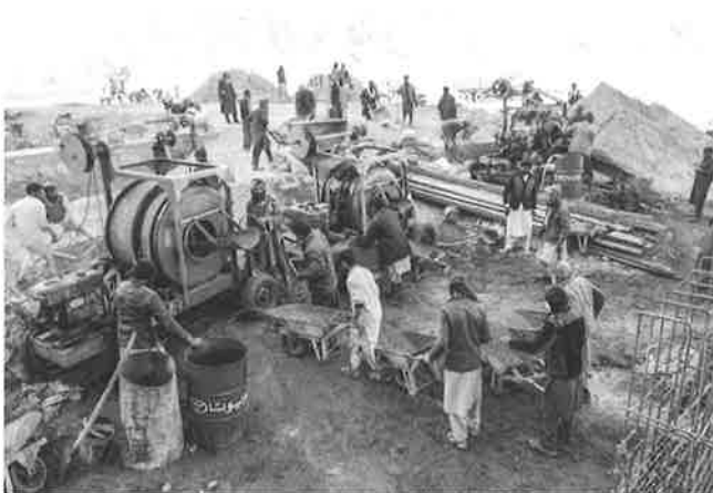
バルカシコート堰・取水門の工事風景。床面のコンクリート打設作業中。(2021年1月13日)
