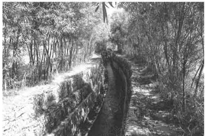
ガンペリ主幹排水路の現在。田畑からの浸透水を一挙に集め、クナール 河へ戻している。(2021年5月24日)
