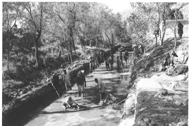
マルワリード用水路床面のソイルセメントライニング作業 (2020年12月3日)
