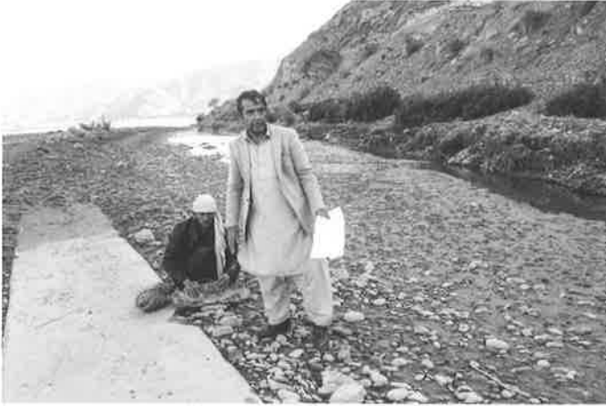
施工前のバルカシコート取水門上流。土砂で埋まった突堤付近にて調査中のディダール技師(2020年12月9日)
