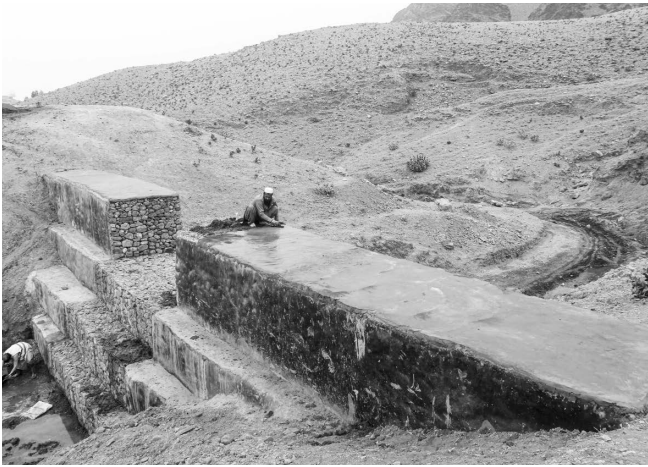
ナージアン（ホラガイナウ）の完成間近の砂防堤（2025年12月22日）
