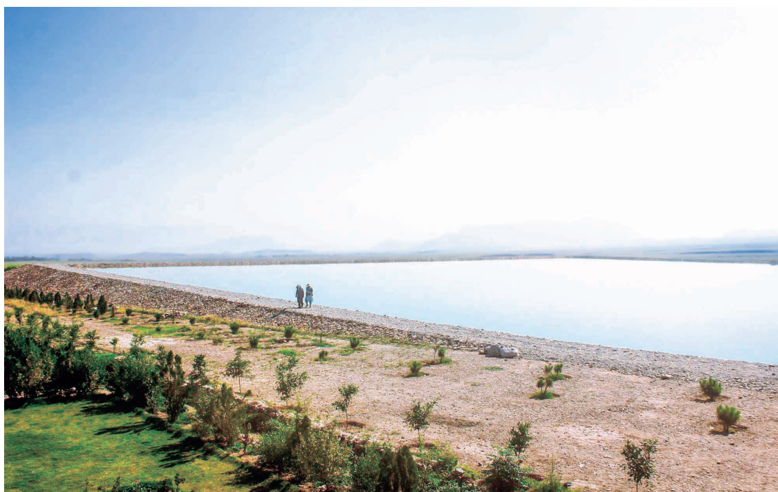
モラヘイル用水路末端に造られた大貯水池。3月29日にアフガニスタン東部全域で豪雨があり、48,000m 3 の貯水容量を持つこの池は、洪水を貯水し満水となった。写真は降雨から1ヵ月後。毎日14,700m 3 の水が地中に浸透し、地下水を涵養している。PMSのディジタル技師は「毎日雨が降っているのと同じ効果がある!」と述べ、池を見にやってきた村人や役人たちは、大きな喜びを口にする。(2026年4月29日)
