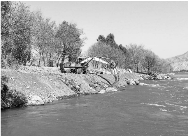
ミラーン堰下流の護岸補修工事（2026年3月2日）
