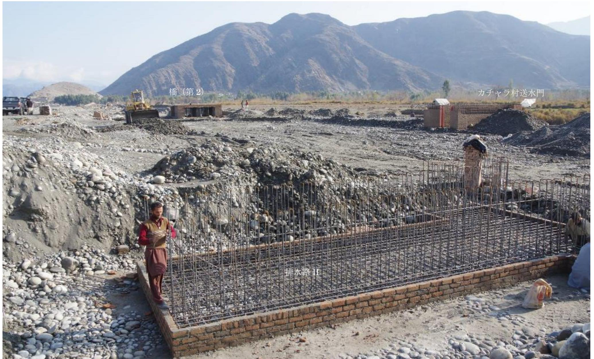
同建設風景。排水門Ⅰが注ぐ排水路は、長さ約5kmも続く湿地で、肥沃な泥土と有機物が堆積している。やがて耕地となれば、浚渫のための大量排水ができなくなる。排水門Ⅱを設置して将来に備える。2017年1月5日
