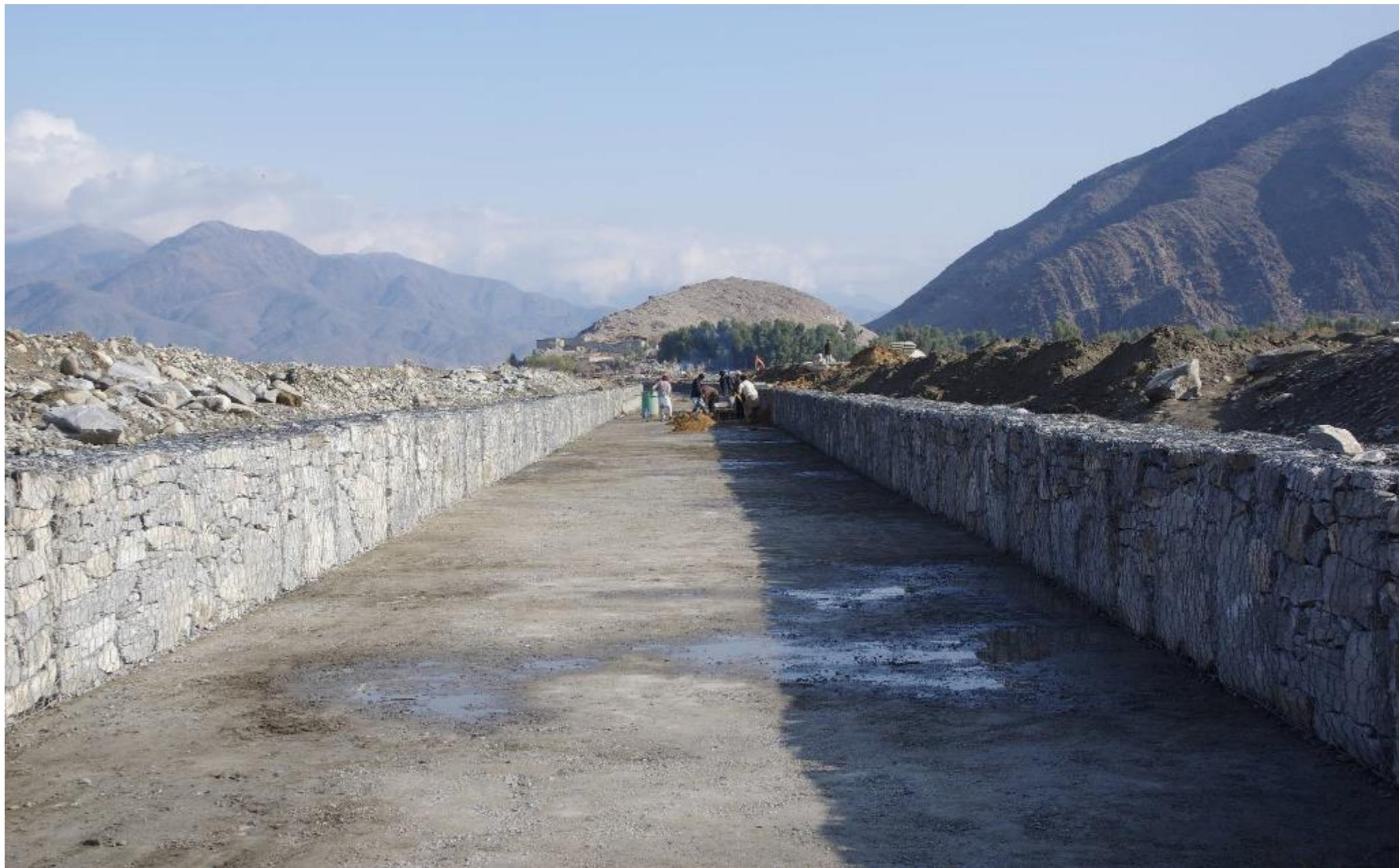
堰平面の最終案（2017.01.05）。大きな洪水吐（舟通しに相当）を設けて、ひと夏の洪水期を観察。一年後に完成予定。現在、冬期に必要な水位は得られている。洪水吐の深さと幅は、最終的に来秋に決定。今冬は洪水吐の両側から石張りを進め、過剰な堰上げを避け、対岸の措置を充分に行う。
