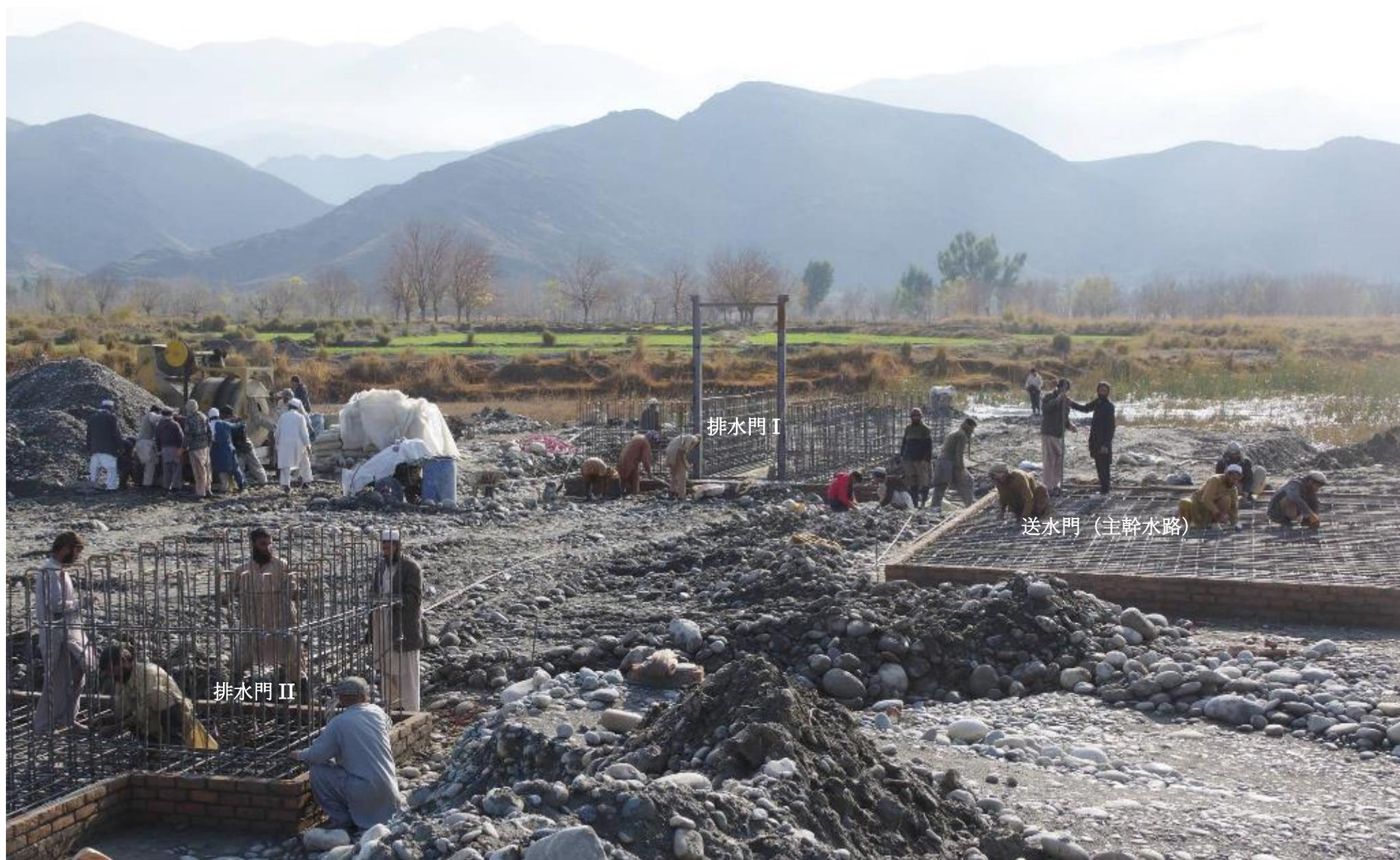
主幹水路は 935mのうち 800m以上の下段を仕上げ、来週から取水門側 100mの造成に入る。1 月中に送水試験の後、上段ふとん籠と植樹が開始される。
