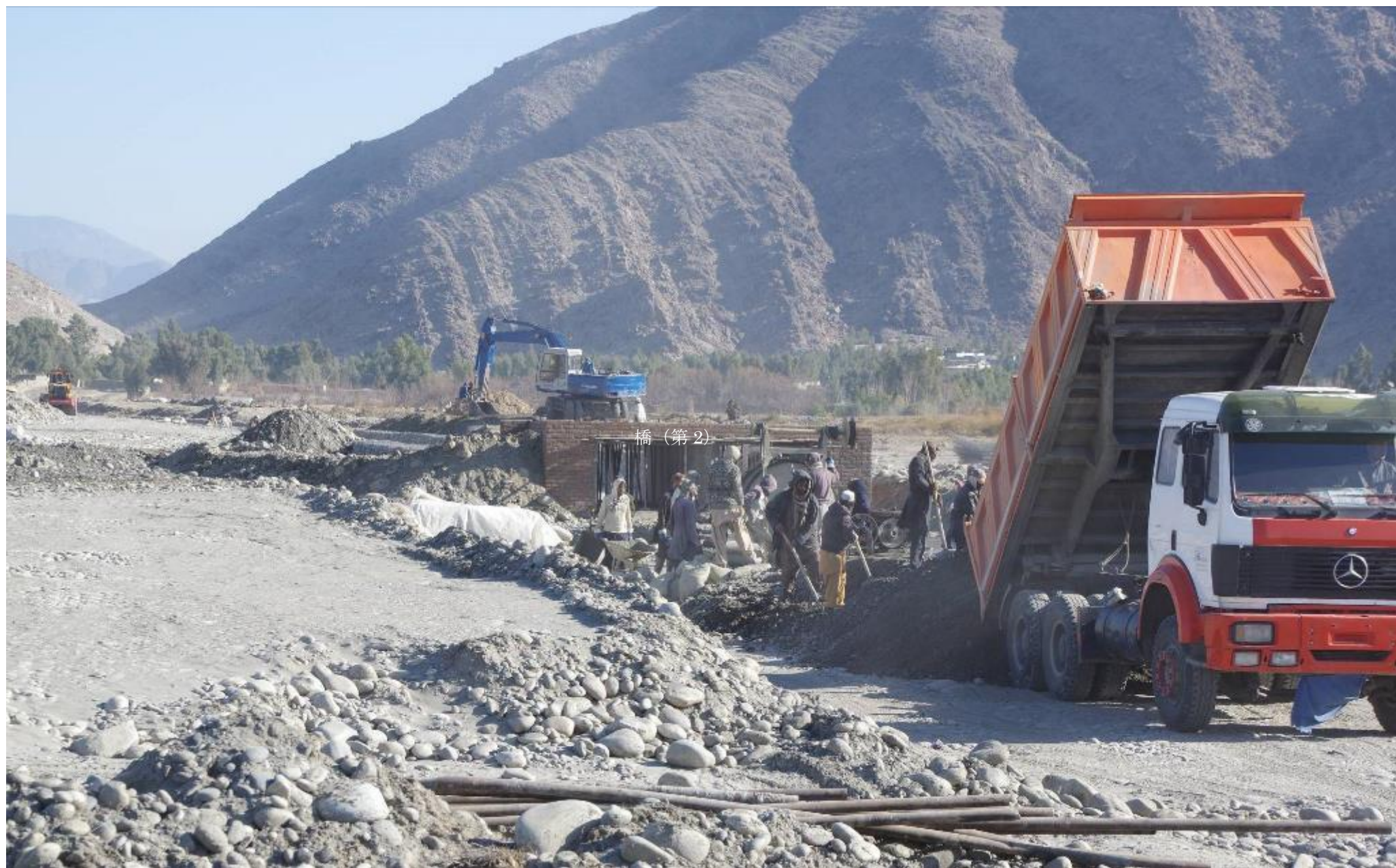
橋を下流側から見る。2017 年 1 月 12 日
