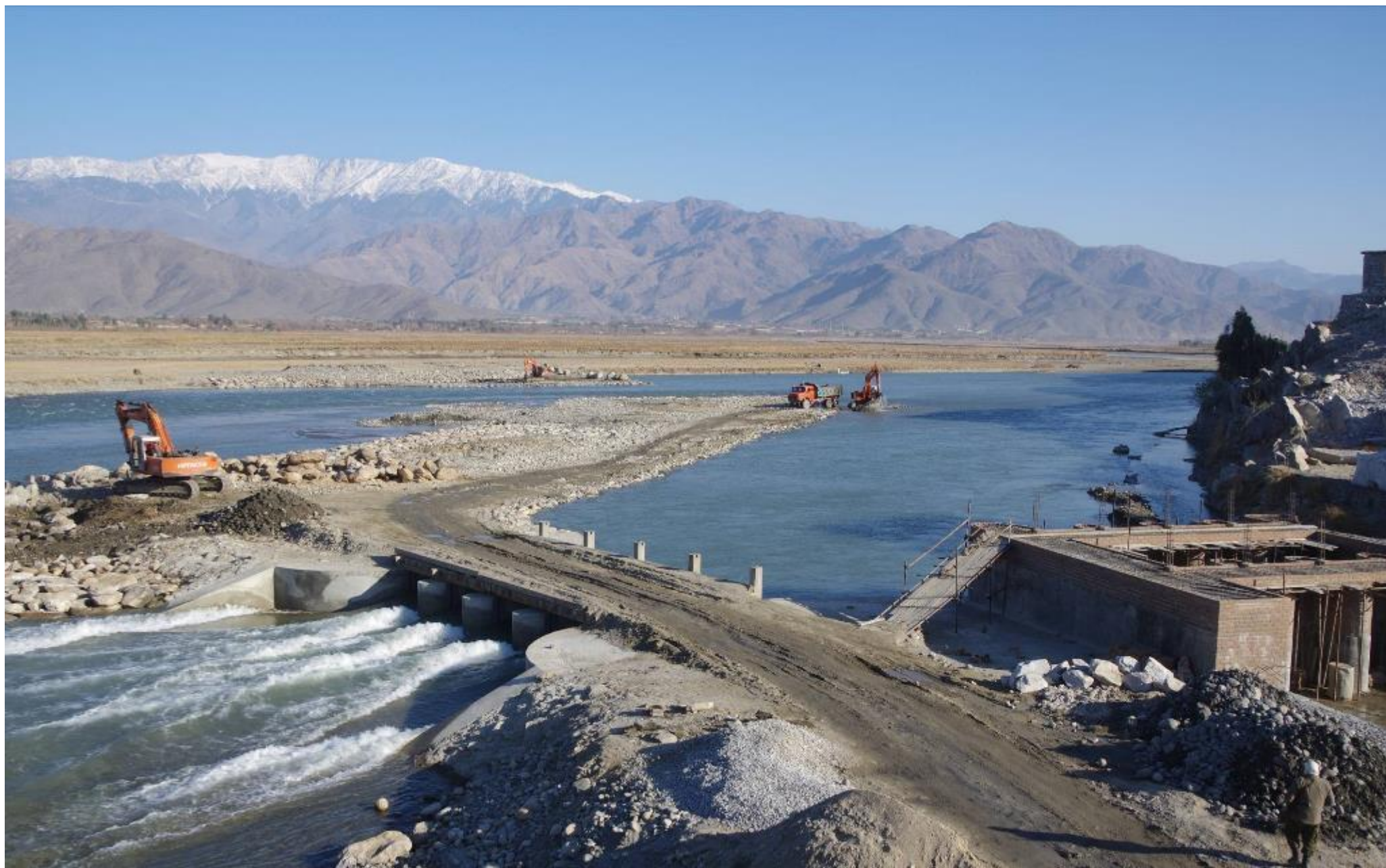
マルワリードⅡ取水口付近全景。2017年1月12日
