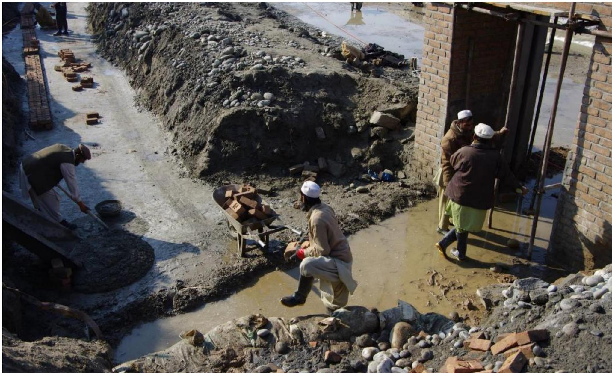
ライニングは130mのうち60mを完了。「レベルとりの鬼」ザビウッラーは、ブディアライ村出身、驚くべき能力の持ち主で、水盛り管だけで水準器より正確に傾斜をとる。読み書きはできないが、優秀かつ質実。このような者がPMSに数多くいて、底力になっている。学歴は賢さと比例しない。2017年1月17日
