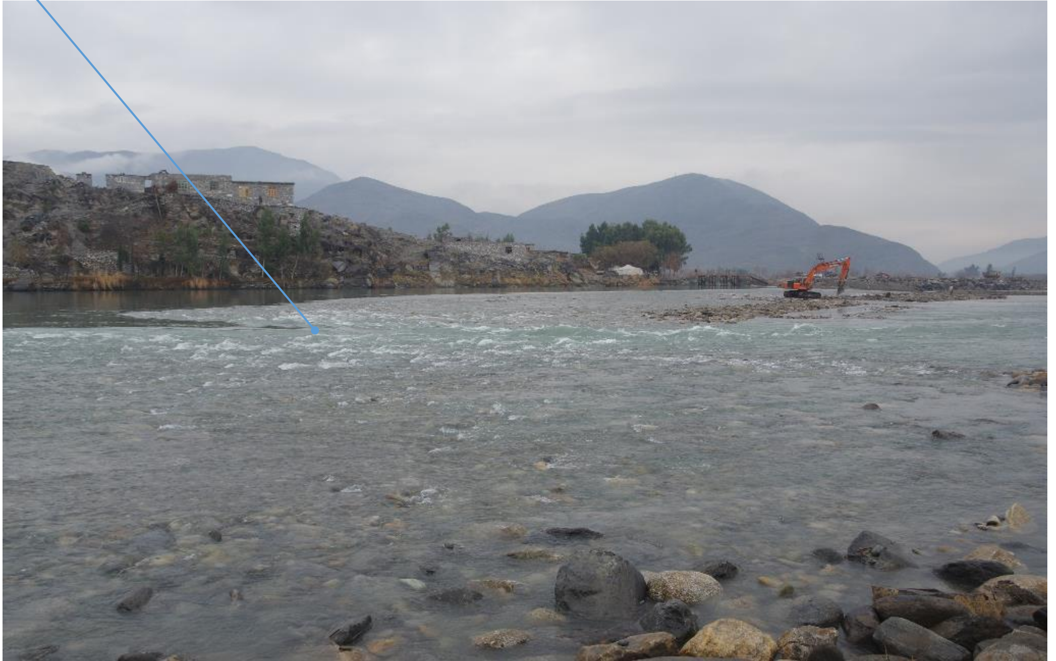
洪水吐きを対岸から見る。2017年1月23日
