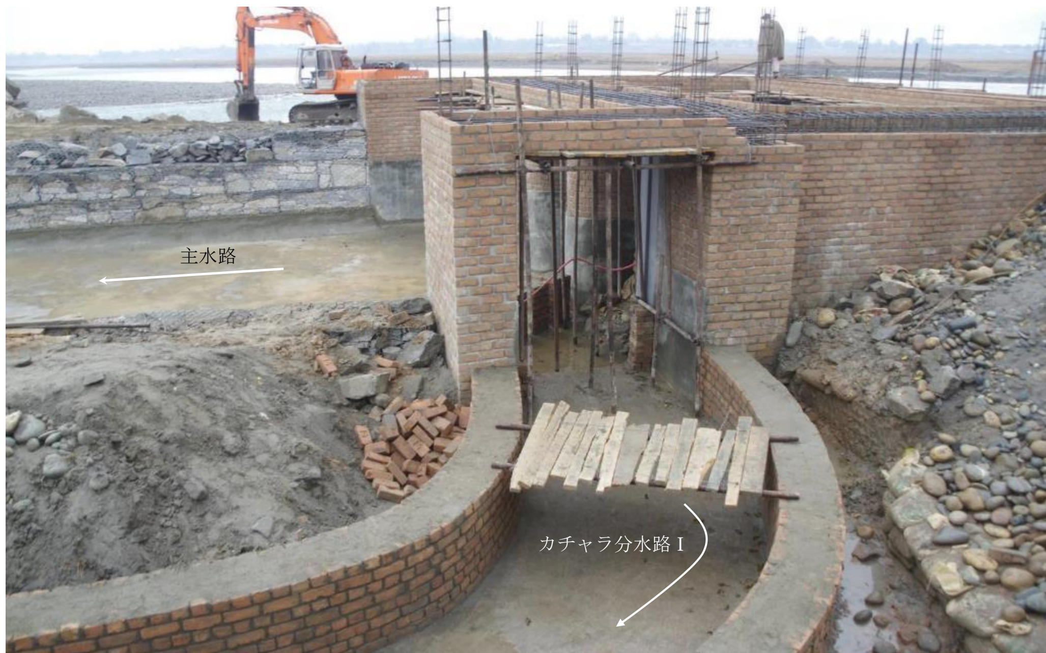
カチャラ分水路 I。2017 年 1 月 25 日
