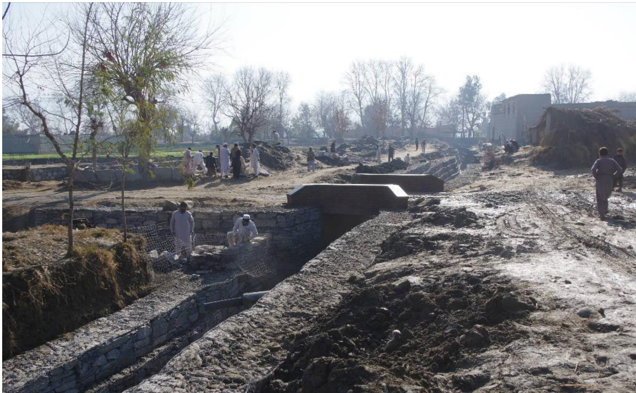
着々と進むガンバリ排水路。X0 橋が要衝で、隣接してシェイワ排水路、チュクレイ排水路が注ぎ込む。2017 年 1 月 31 日
