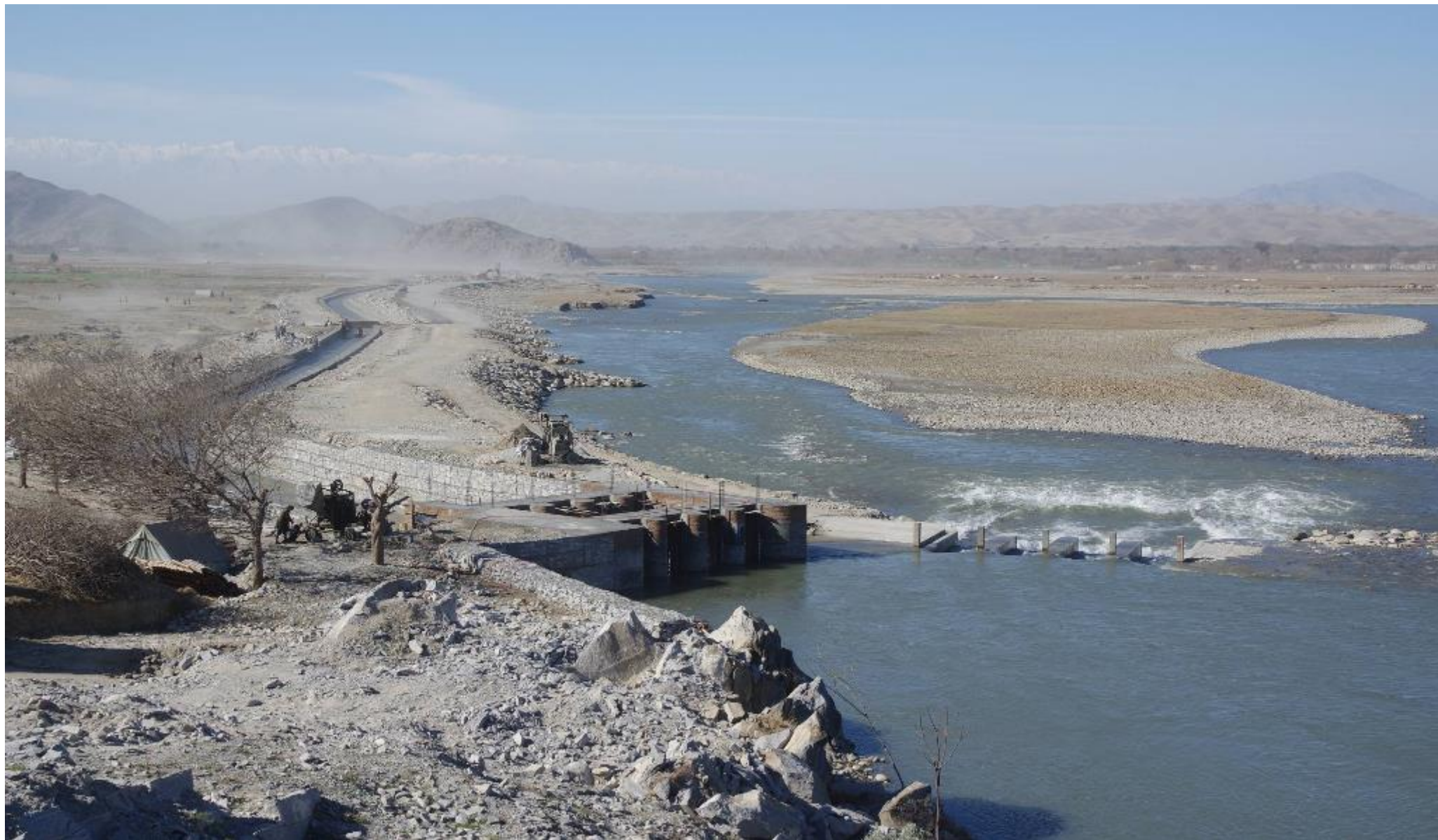
仮工事を終えたマルワリード II 堰と取水門。2017 年 2 月 25 日
