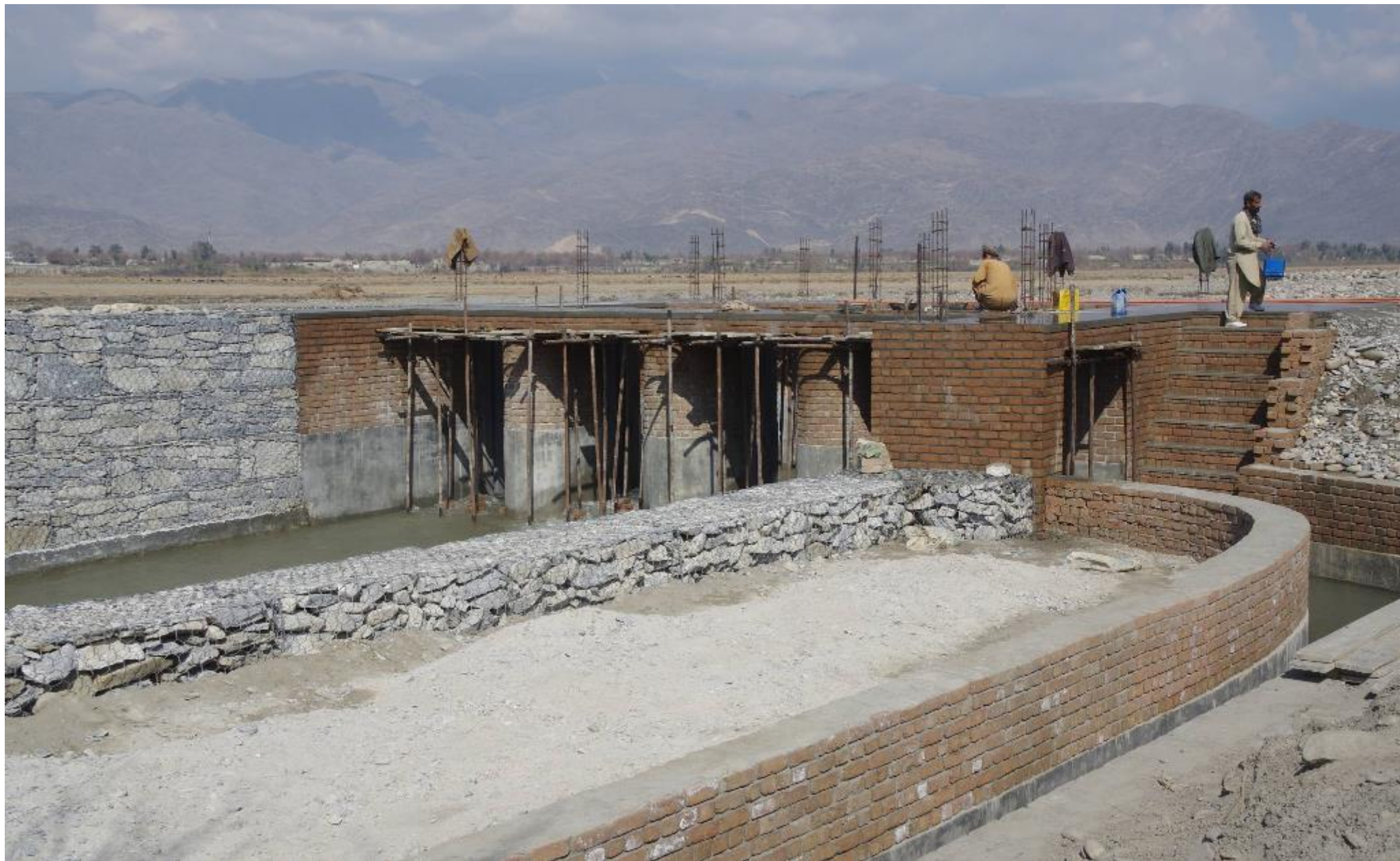
取水門下流側とカチャラ分水路。2017 年 2 月 26 日
