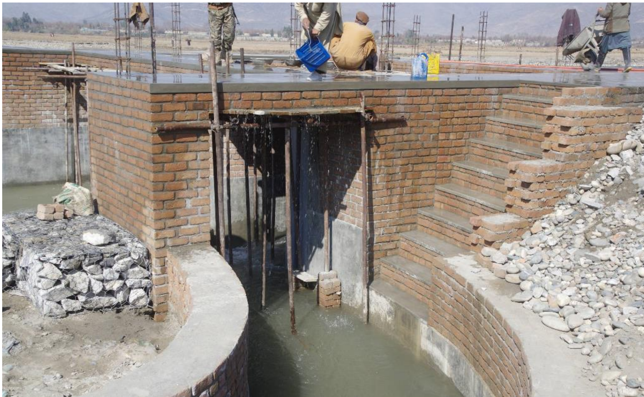
カチャラ分水門。最大 2.0 \text{ m}^3/\text{秒} まで供給できる。実際にはそんなに要らない。2017 年 2 月 26 日
