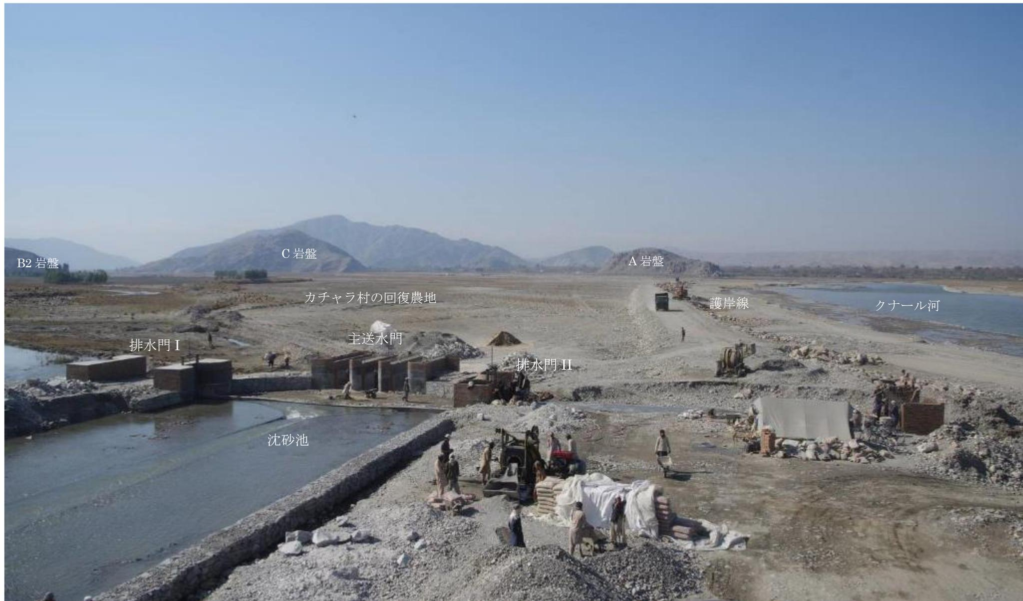
沈砂池以後の護岸と排水溝 1 を示す。同部の川幅は 400~500m を確保し、洪水の溢水に備える。護岸堤防の天端は約 10m を確保。表法に 50m ごとに石出し水制、洗掘に備える。遠くの山はスピングアル山脈。2017 年 3 月 1 日
