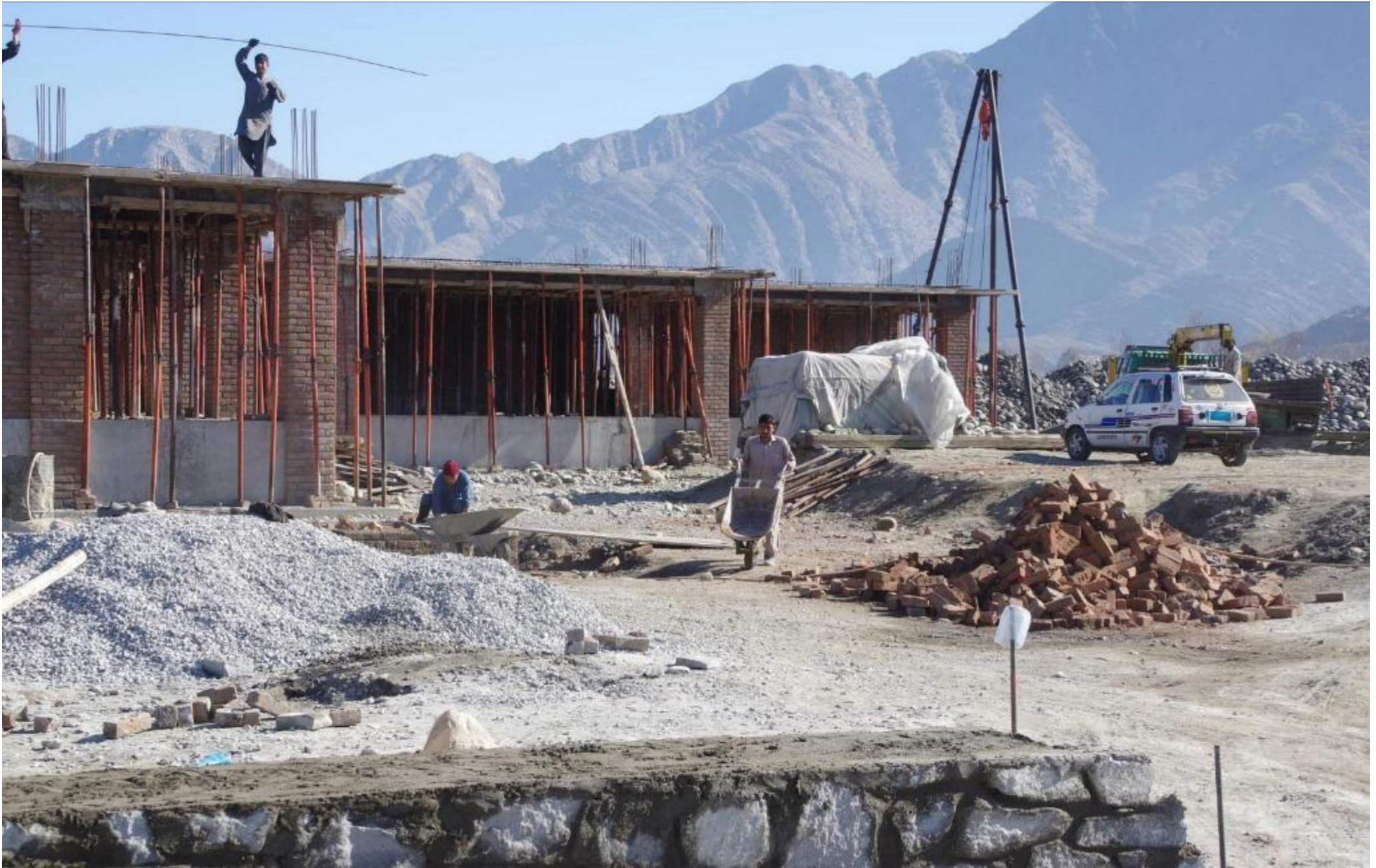
建築中の訓練所（PMS職員駐留所）。二階の建築が始まっています。2017年3月4日
