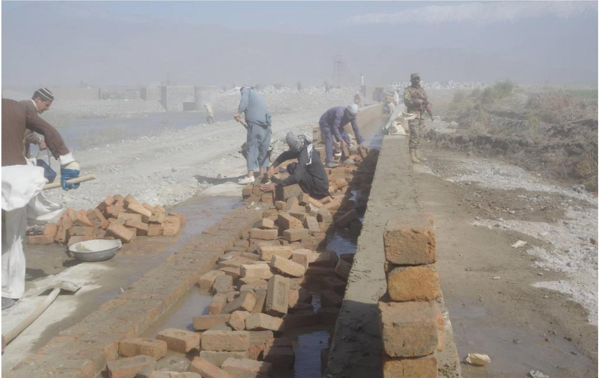
旧コーティ分水路。たびたび洪水が流入、土砂が堆積して湿地を形成している。分水路は粘土質の堆積土を砂利で置換、水路の基礎を作る。小さいながら主幹水路と同様、ソイルセメントでライニングが行われる。土は肥沃で、パキスタンから帰還したカチャラ村民が争って耕地を拡大している。「今夏に水稻栽培が広がる」と村民は予想している。水さえ豊富にあれば、コメはアフガン農民に魅力的な作付だ。2017年3月11日
