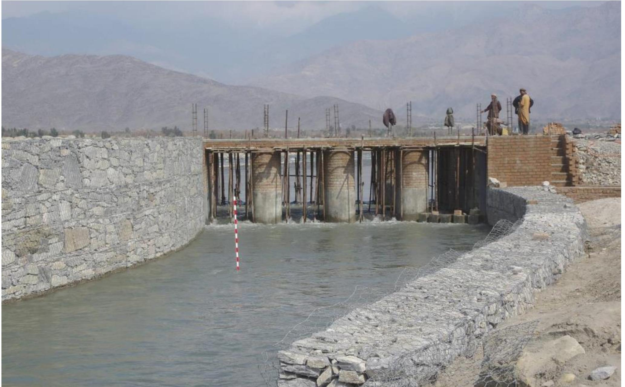
全開時（流入量；毎秒約 5 m<sup>3</sup>）の沈砂池の様子。排水門 II だけを全開している。送水門床面の水深は 80～85 cm で安定、2017 年 3 月 7 日
