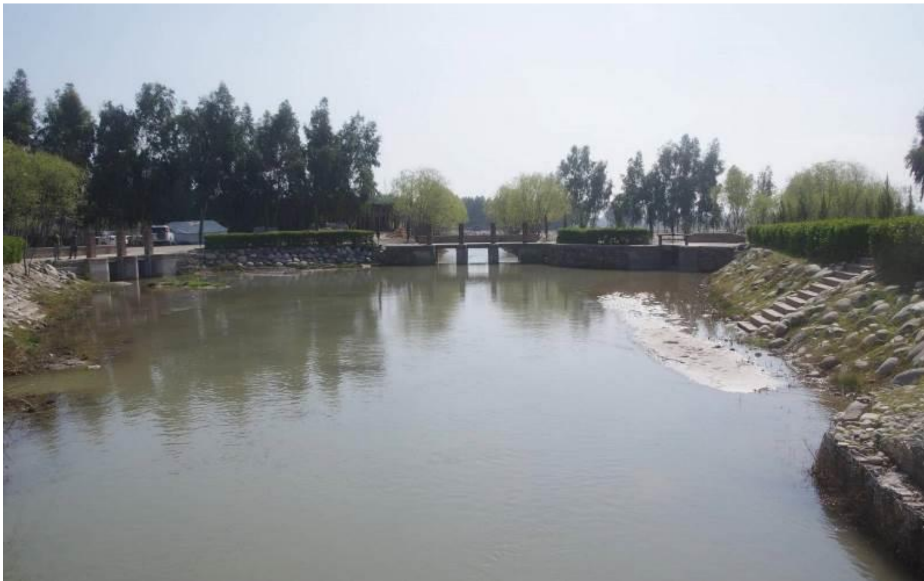
沈砂池の現在。ジャララバード市民に公園としても利用される。2017年3月9日
