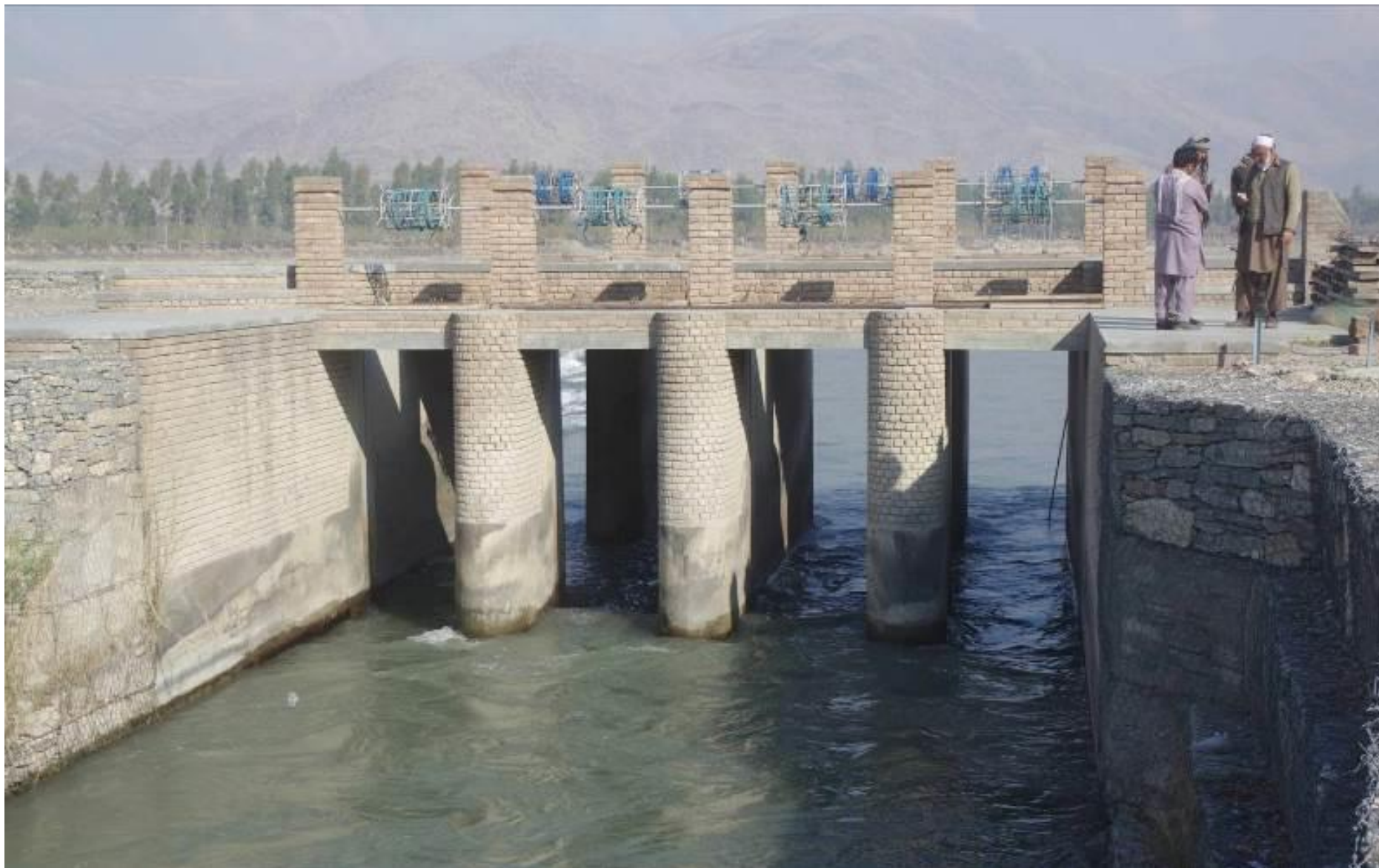
カマ第二堰取水門。2017 年 3 月 9 日
