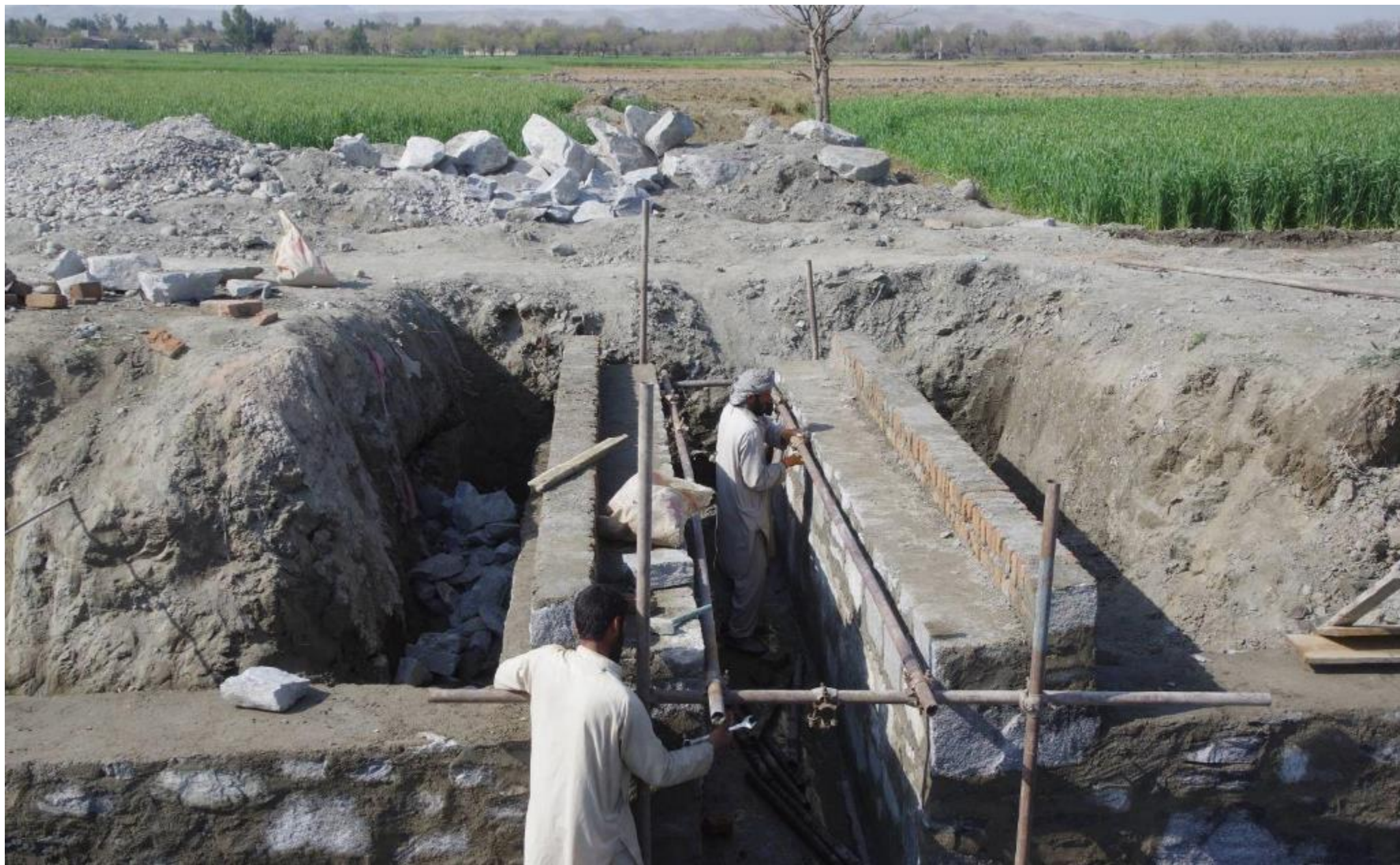
旧湿地（シギ・チュクレイ村下流）からの排水口造成。約 800m地点。最後まで湿害が残っていた領域。湿原が小麦畑に変わっている。2017 年 3 月 16 日
