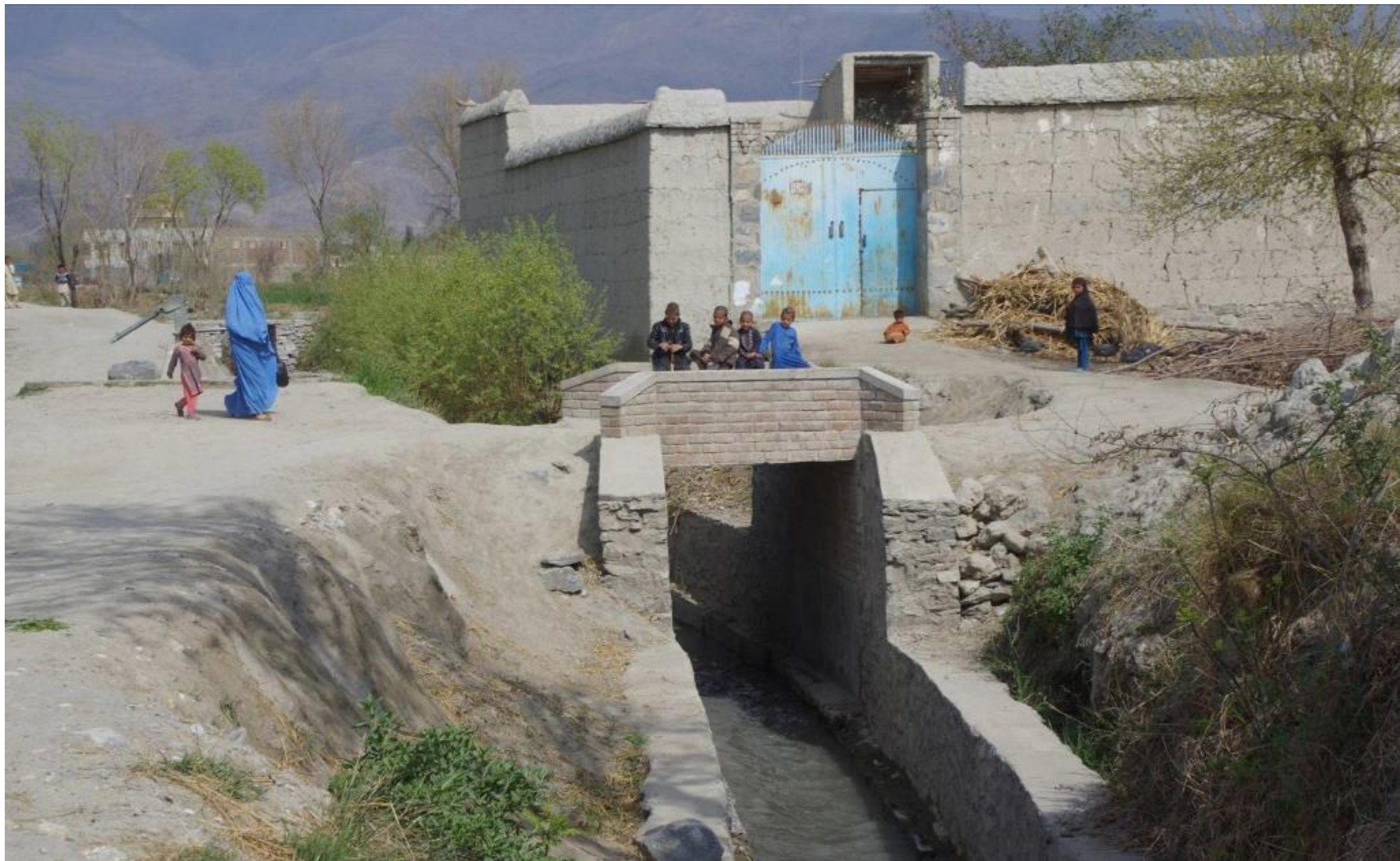
歩道橋。約 450m地点。まだ兩岸の蛇籠壁が置かれていない。2017 年 3 月 16 日
