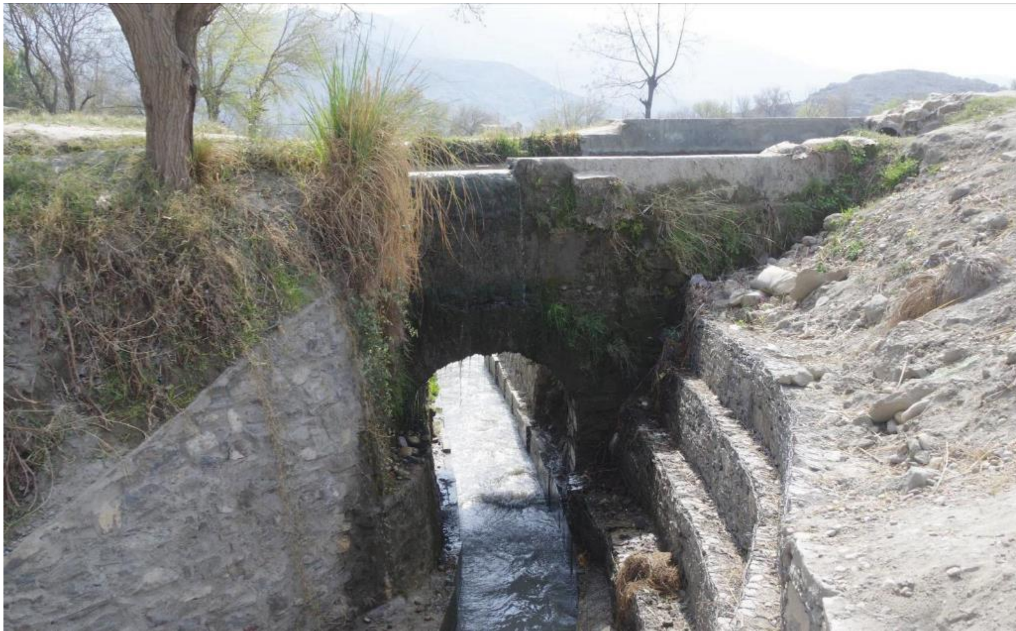
約 400m地点の水道橋（シギ分水路 2）。古い施設の改修を行ったもの。2017 年 3 月 16 日
