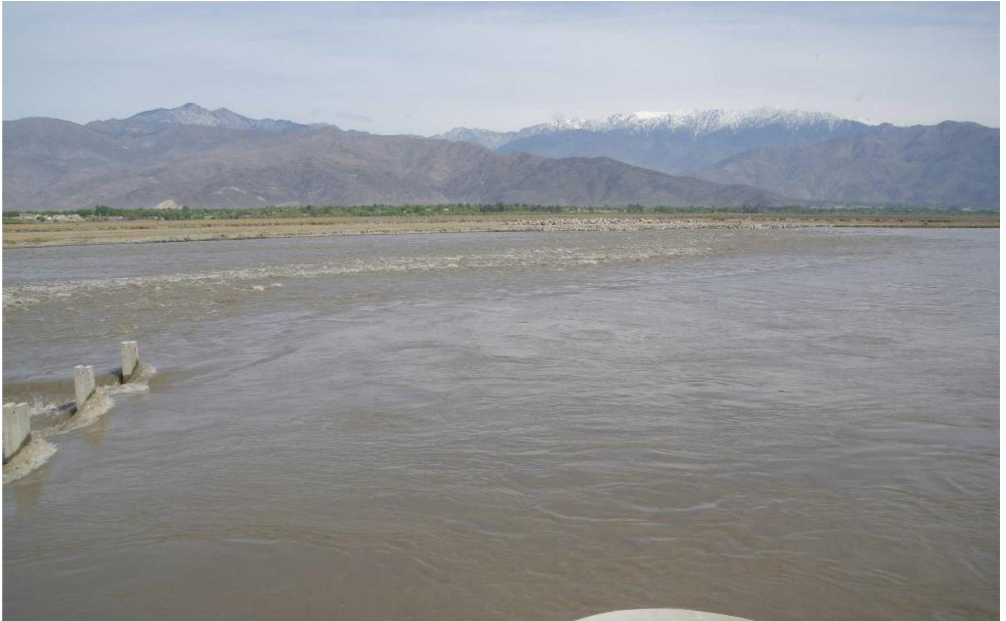
砂吐き（＝可動堰）部分の現在。矩形の長さだけ越流長も伸びるのが分かる。たたき部分は、まだ改良の余地がありそうだ。2017年3月30日
