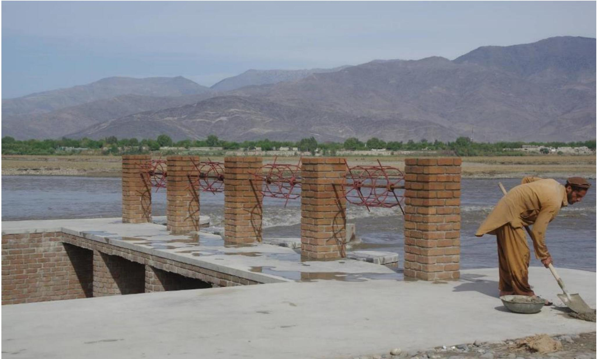
護岸と柳枝工。石出し水制を 50m 間隔に置き、流れの緩やかなところに柳枝工を施す。この形がほぼ定着した。2017 年 3 月 30 日
