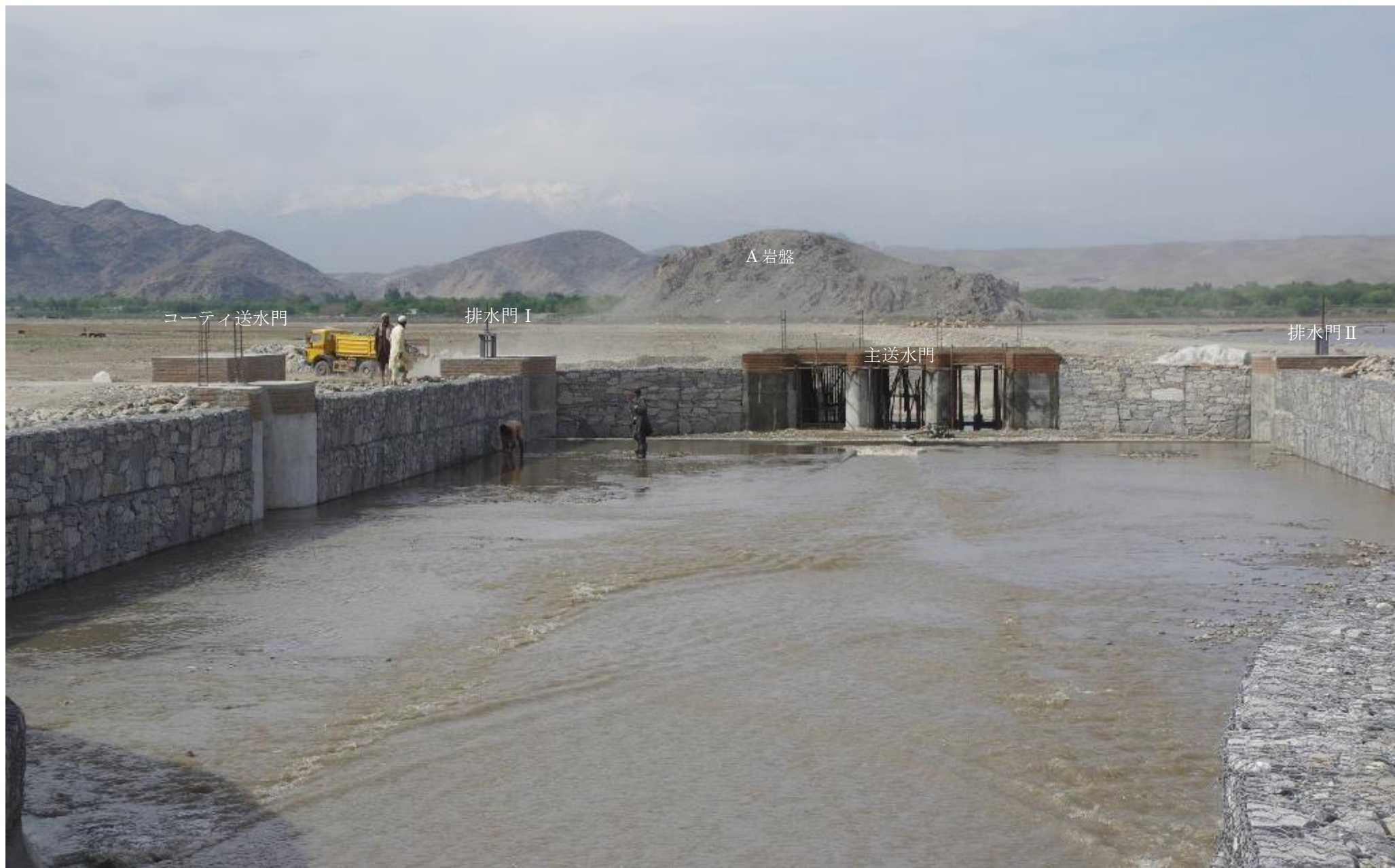
沈砂池 I。内部と各水門を完成した沈砂池。2017年3月30日
