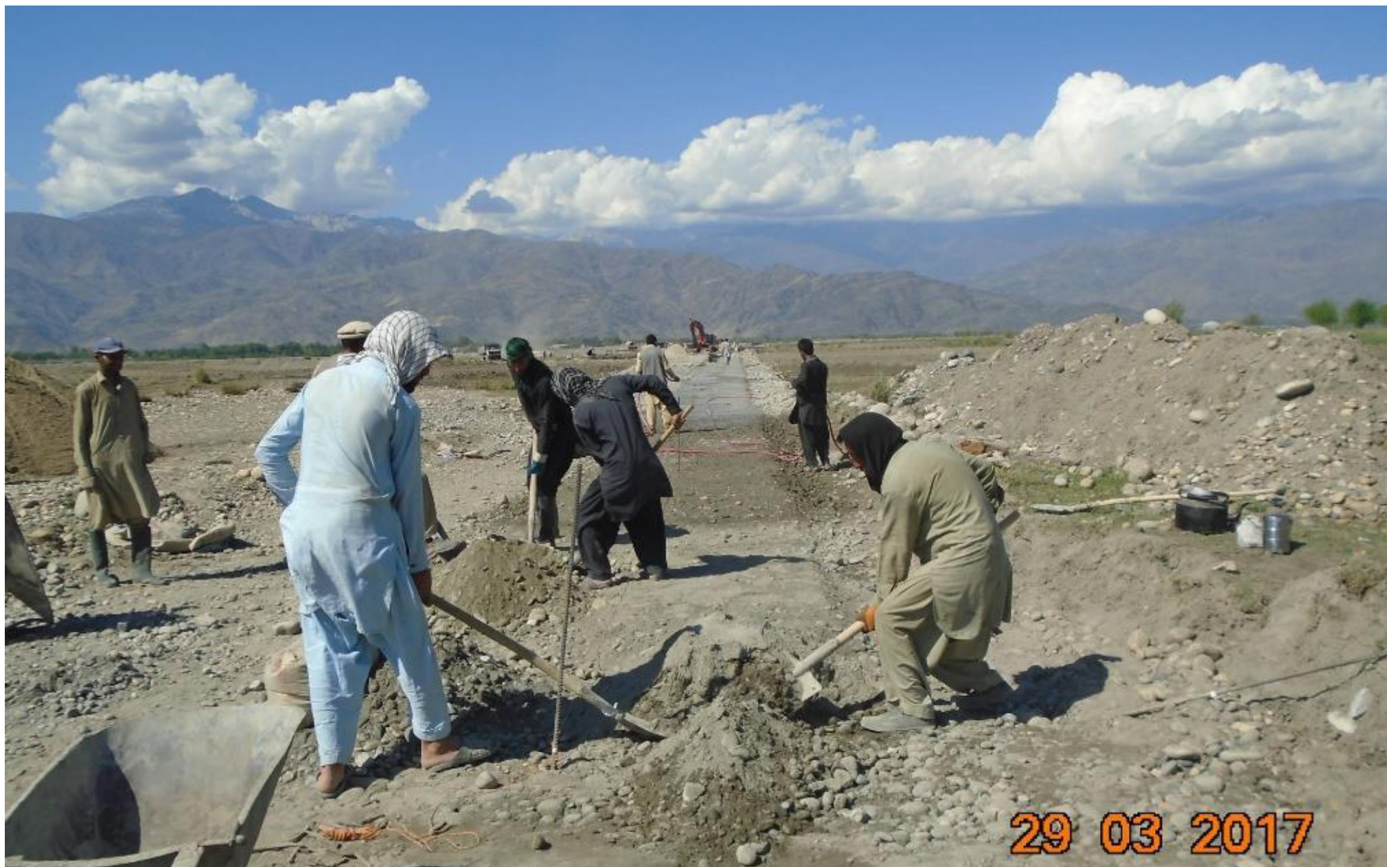
コーティ分水路のライニング作業風景。村民は一般に勤勉で、作業に慣れている。2017年3月29日（ファヒム技師撮影）
