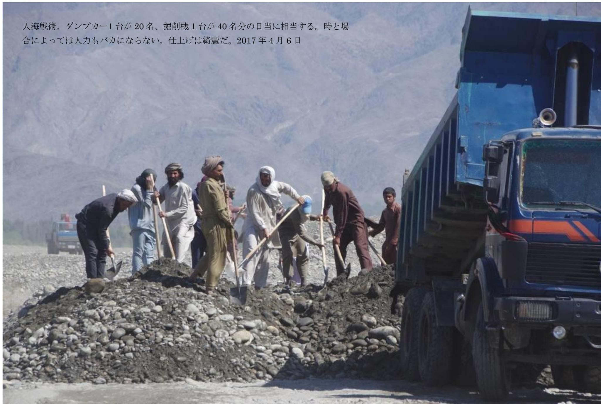
昨年仕上げた分流閉塞のしめきり堤（取水口から約4 km地点）。石出し水制は50m間隔。2.2 kmが既にあり、カチャラ村から下ってきた護岸線と間もなく連続する。連続すると、一気にベラ村まで作業地点を伸ばすことができる。
