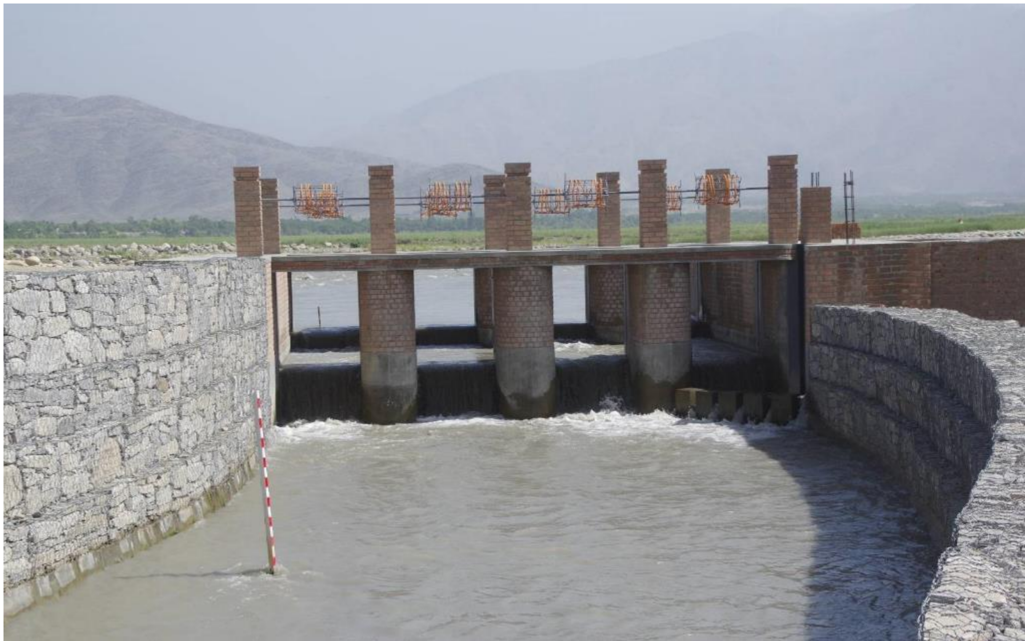
取水門下流側。おなじみの二重堰板方式。2017 年 6 月 12 日
