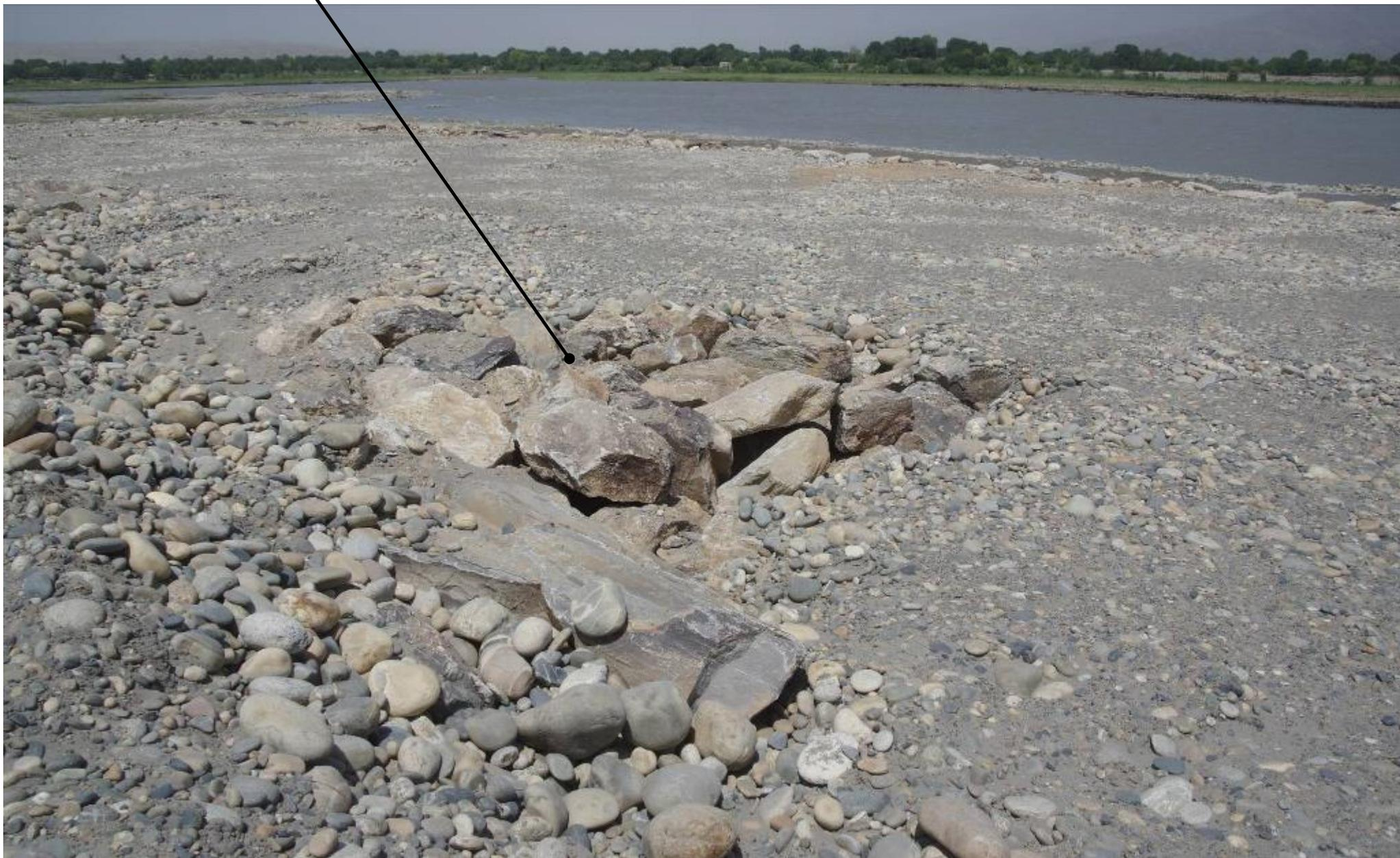
河の増水と共に発生する浸透水。今回は初めから用水路に浸透水を取り込む設計で、耕地の湿地化を防ぐ。川沿いの用水路で、時々流量が取水量を上回るのはこのためだ。筑後川沿いでは、大石堰の水路がこれに似ている。2017年6月12日
