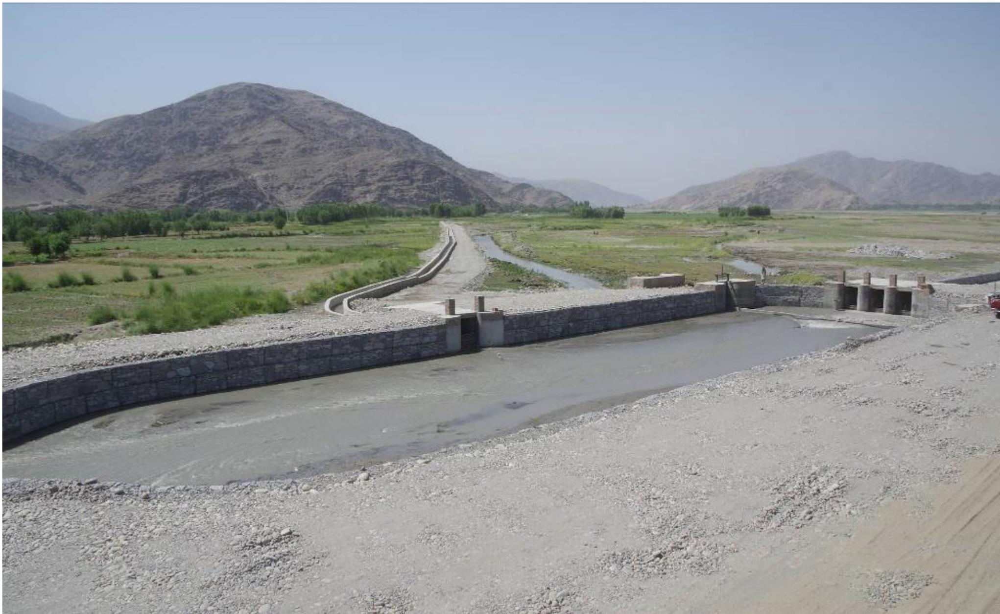
コーティ用水路と排水路1。主要排水路2がクナール河側にあつて、こちらは緊急用。洪水時に河の水面が高くなつた時だけ、比較的小水量が流れる。現在タラーン村のためだけに流されている。湿地はこの数カ月でずいぶん減り、水稻の作付けが期待されている。2017年6月12日
