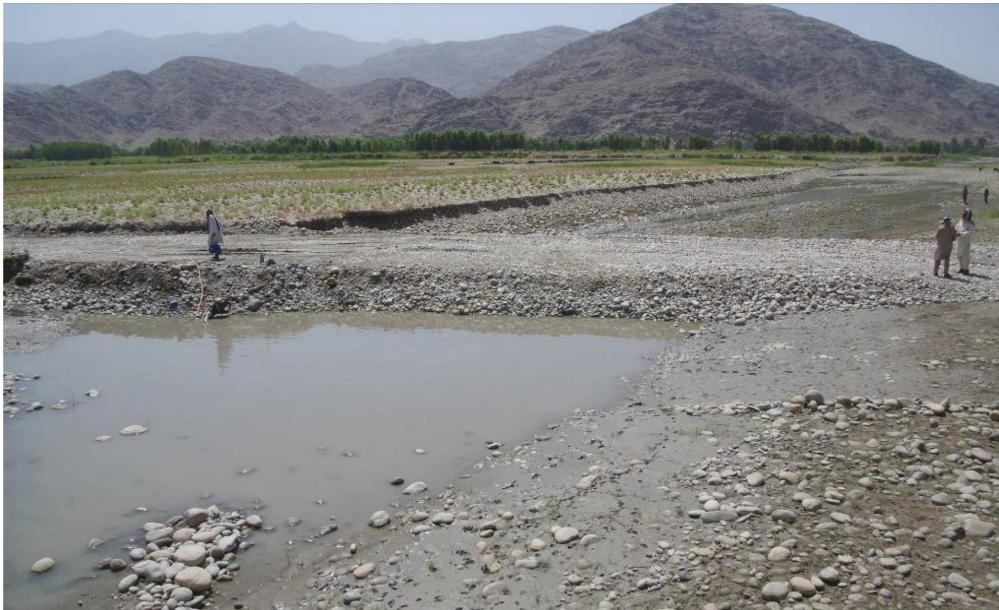
洪水進入点は幅 100m、密に埋設水制を置いて埋め立てている。小さな丘を作って樹林帯を置き、万一溢水しても大丈夫なようにしている。2017年6月12日
