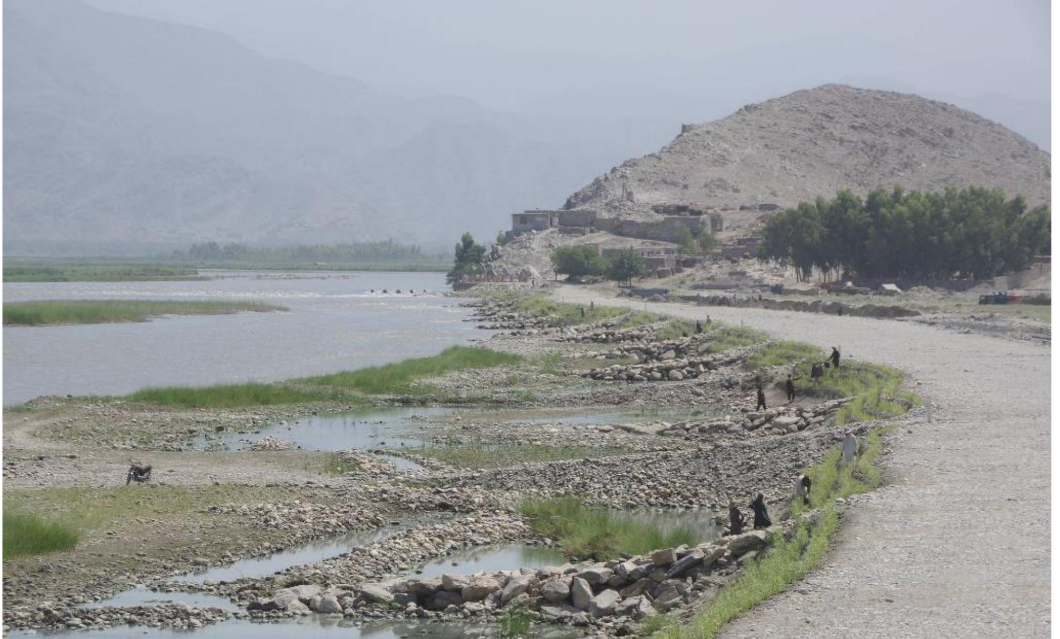
1200m地点。一般にこの地域は急傾斜で、所々に step down を設ける。急斜面には後で巨石を配置して粗度を増し、流速を殺す。レベルに合わせて自在に用水路側壁を造成できるのもふとん籠の利点だ。2017年6月12日
