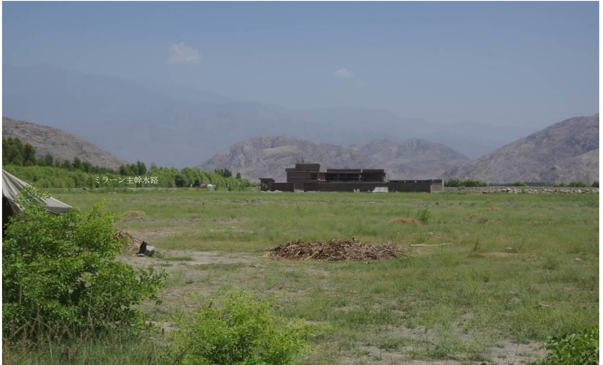
建設中の訓練所。二階部分を造成中。2017 年 6 月 14 日
