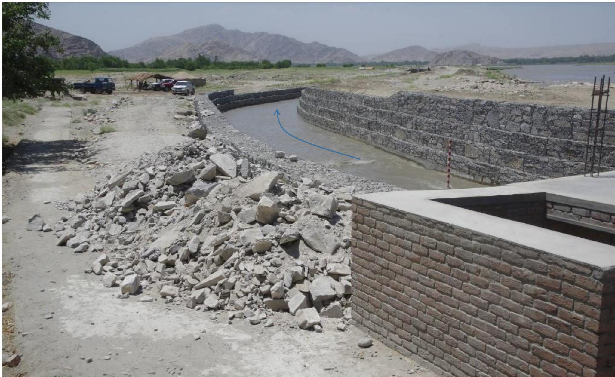
水路壁下段は、現在 1.3 km地点を造成中。上段施工は通水してからでもできる。早急に送水できるように、まずは下段壁建設を急がせている。近辺の村からくる労働者は約 150 名、一般に勤勉で手抜きがない。やはり石積みが好きで、丁寧に仕上げる。農民は全て有能な石工なのだ。短期間に習得し、PMS 出向のブディアライ組は退いた。2017 年 06 月 29 日
