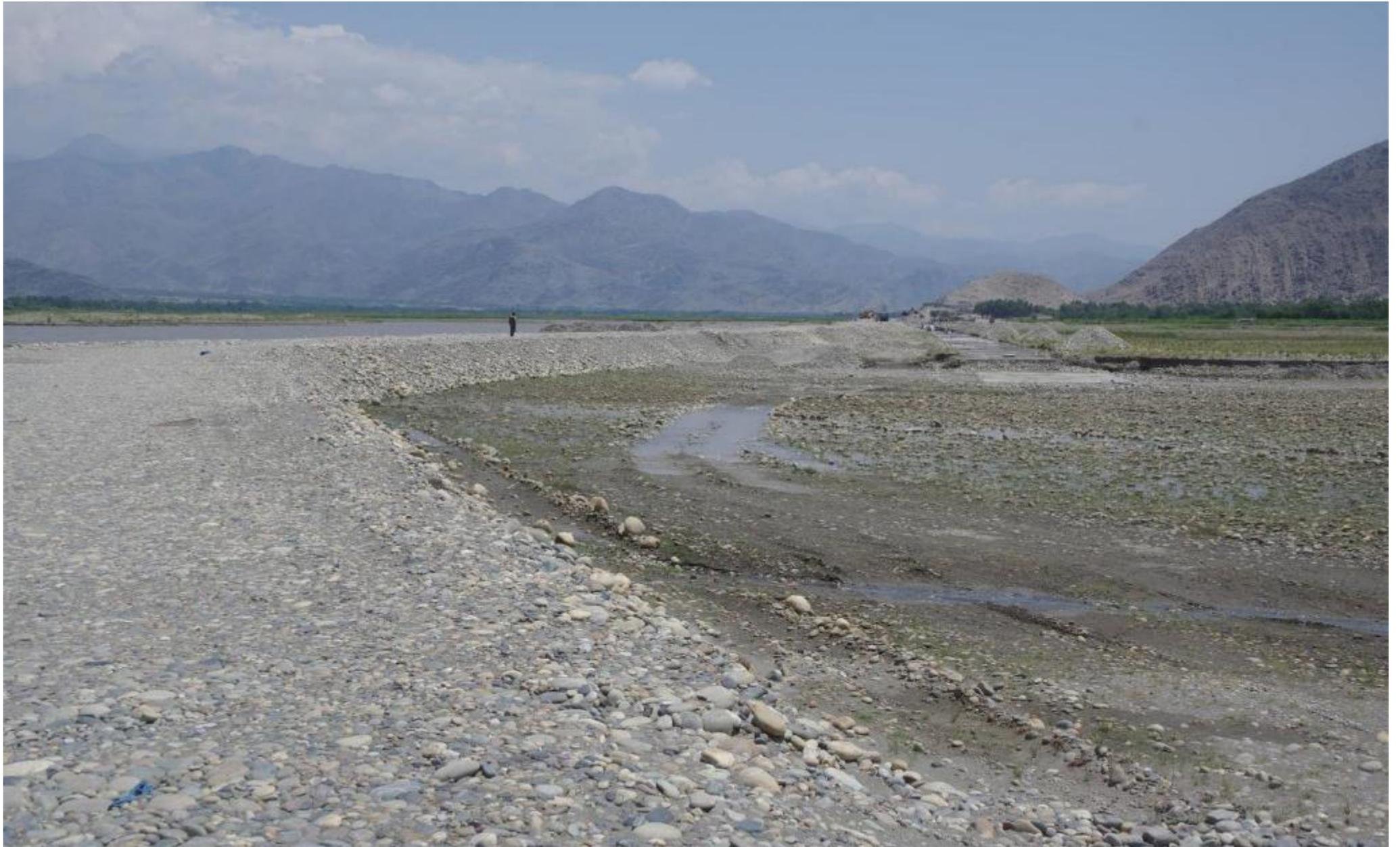
新河道の掘削造成（ショートカット）。閉塞した分の水量を流すべく、川側に「代行河道」を作る。1500m 地点付近は砂利堆積で河床が高くなっており、河道閉塞は高水位を誘発する。要するに、水の逃げ道を作るということだ。掘削幅約 50m、長さ 250m、掘削で得る膨大な砂利は、堤防工事に使われる。2017 年 7 月 2 日
