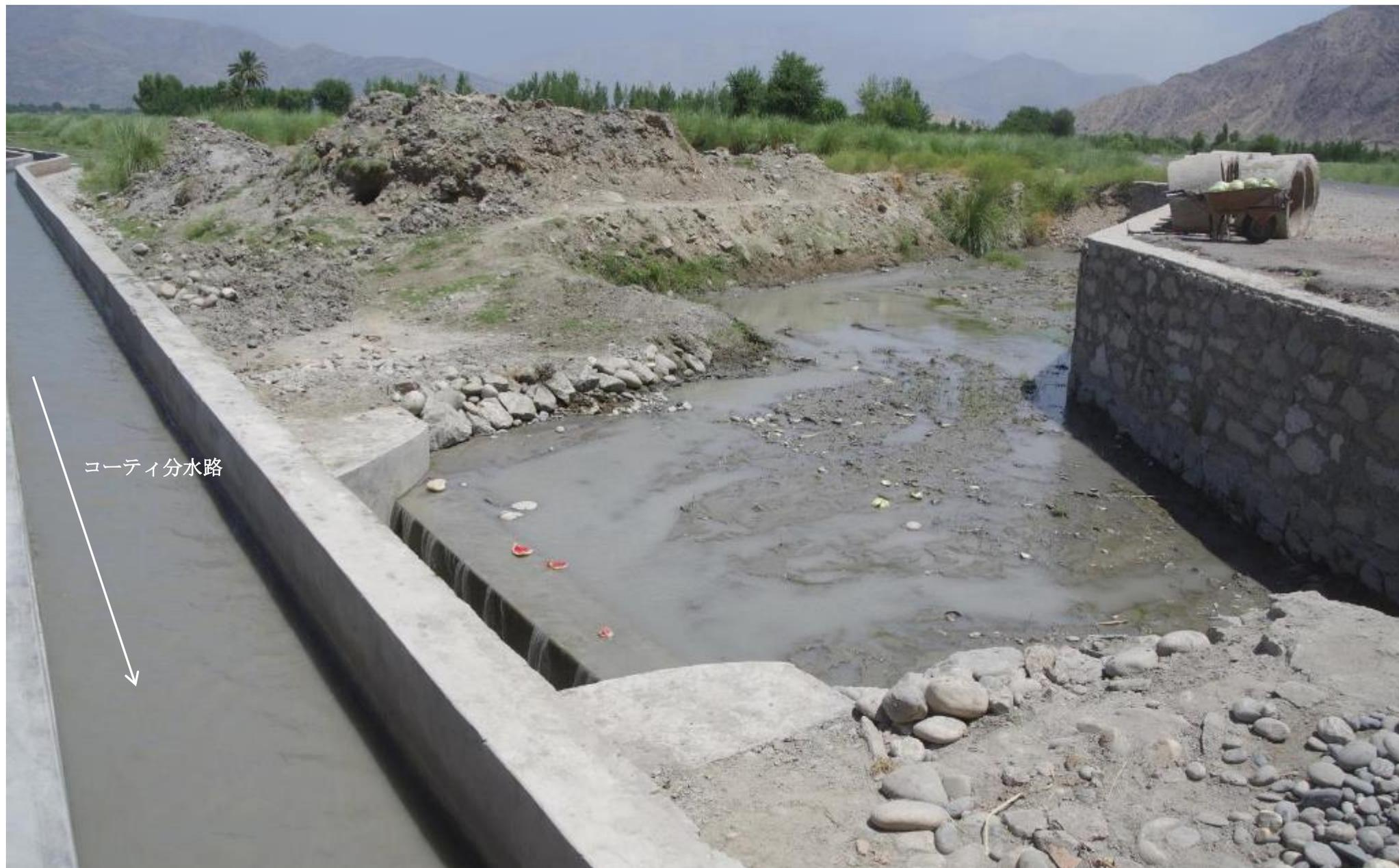
コーティ分水路は  $3.5\text{m}/1050\text{m}$  ( $= 1/330$ ) の相当な急傾斜で、急流が下る。夏休みの子供がスイカ運びの「舟運」に利用する。2017年7月5日
