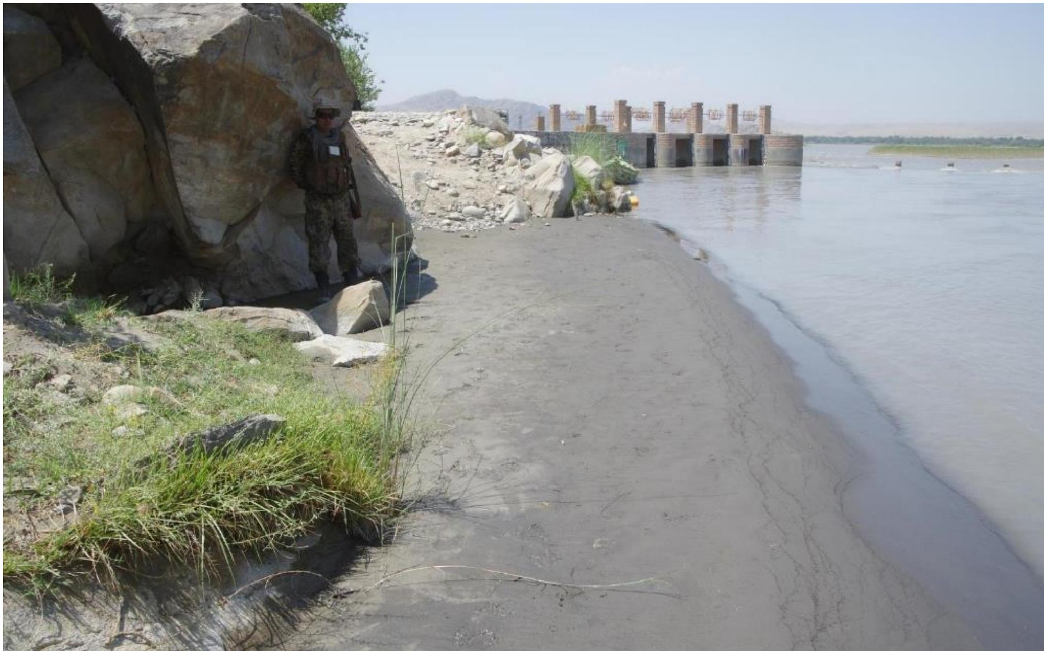
1500m 地点、「特別堤防」の基礎工事。何が特別かといえば、堤体幅の厚さと基礎の頑丈さだ。中に巨礫の水制が埋め込まれ、さらに川側に根固め工が施される。最終的な幅は約 80m で、ガンベリ沙漠横断路の Q2 貯水池の堤防に次ぐ。過度に高くせず、大洪水時に流入量を減らし、流速を減殺することを目的にする。堤体は粘土質のものは使わず、粒径の大きな砂利を使い、根気よく水を注いで砂を石の空隙に詰めていく。両側斜面に樹林帯を作る。2017 年 7 月 6 日
