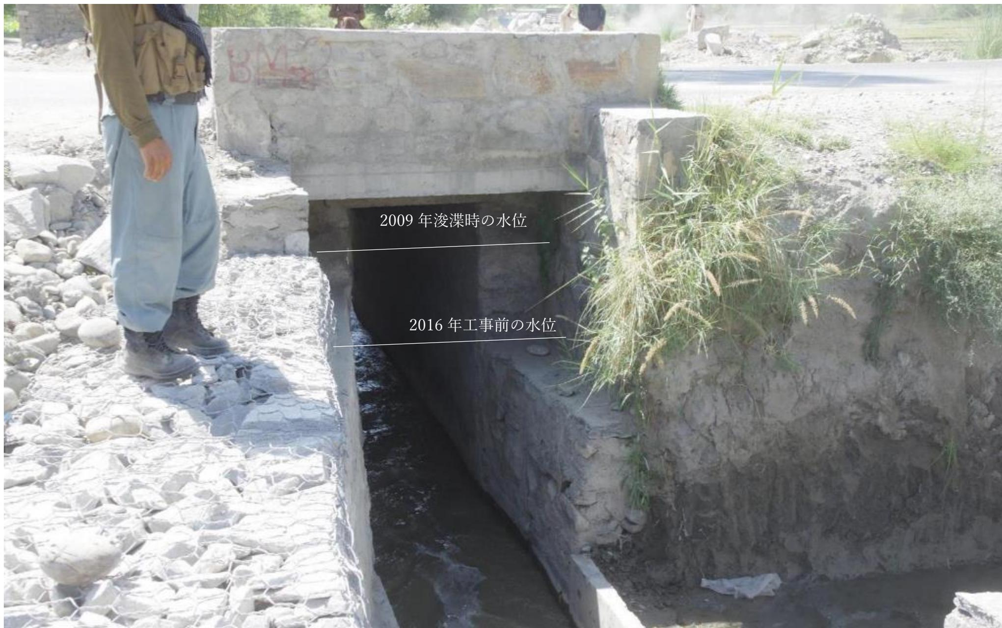
水位低下は約 2.5m 以上、場所によっては 4m 以上、湿地は乾燥し、安心して作付けできるようになっている。灌水すれば蓄積した塩類も流れて消えていくから、一種の土壌改良でもある。2017 年 7 月 3 日
