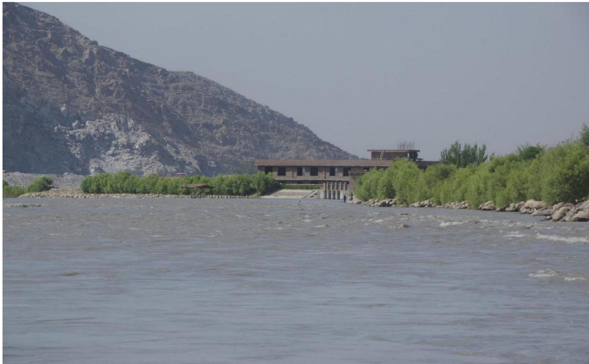
ミラーン堰、第一河道の現在。河川水量の約 15%以下が到着する仕組みになっている。PMS の堰の中では、最も安定した水位を誇る。2017 年 7 月 4 日
