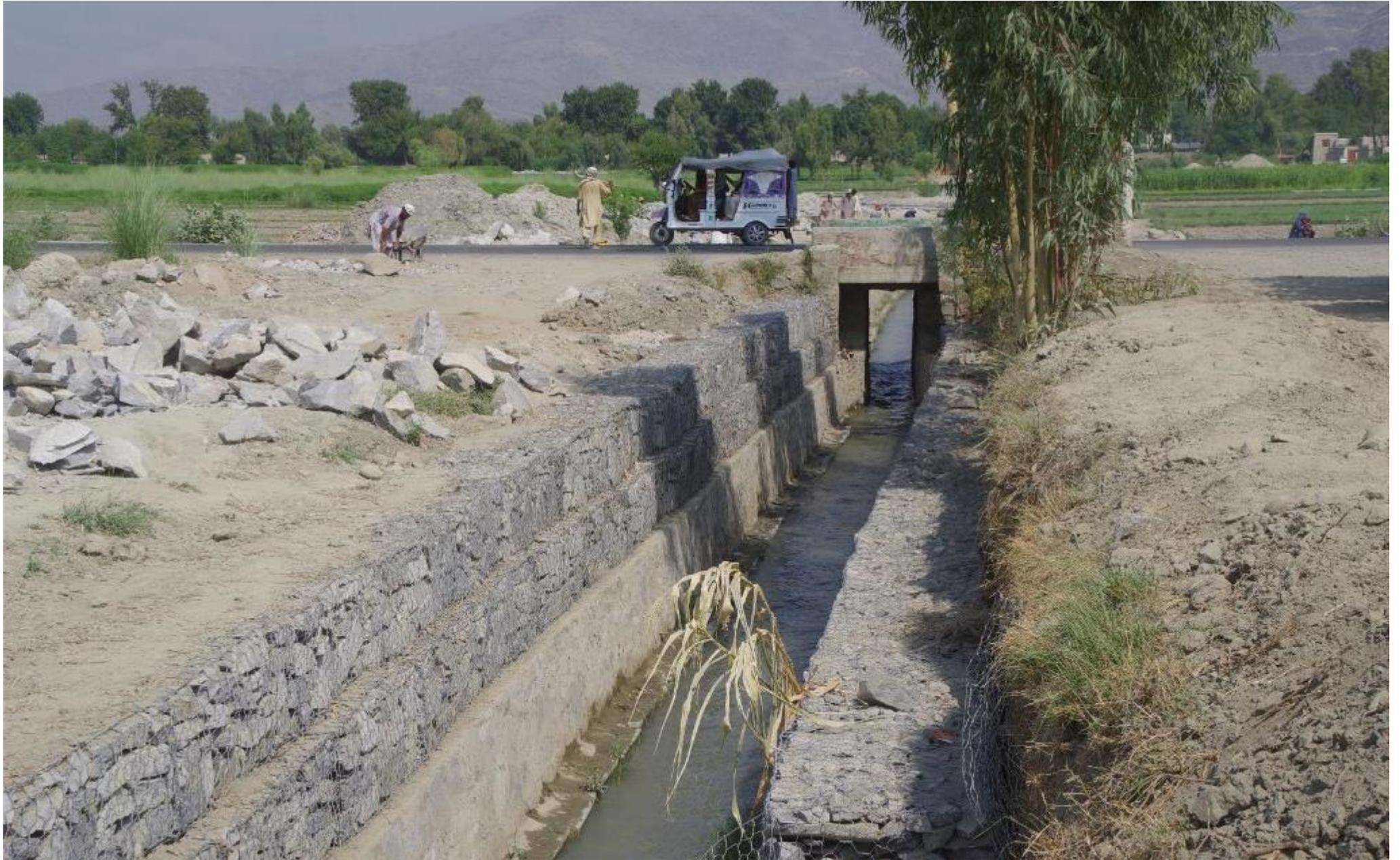
下流側は排水路の深さがそれほどないので、一段または二段の籠積みで済む。石材は現在、カチャラ村の採石場から輸送。美しくて硬いので、籠詰めの石材としては一級品。2017年7月24日
