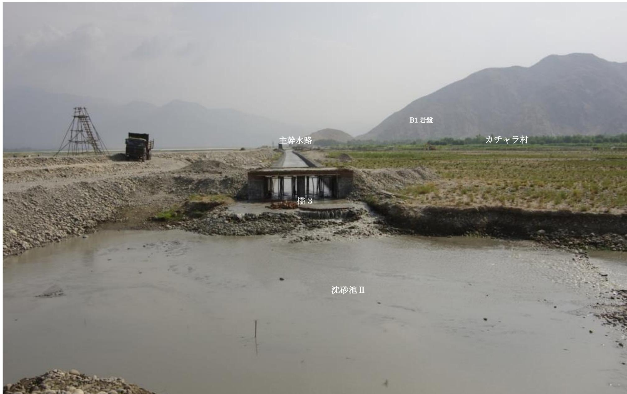
急ピッチで進む主幹水路の基礎。先端は約 2 km 地点。B 区間（沈砂池 II から 3.1 km 地点まで）約 1.5 km を 5.7m の急傾斜で下る。急流で水路床を傷めないよう、途中で段状に落とし、流速を減殺する。かつ幅を 4m に狭め、堆積を防止する。
