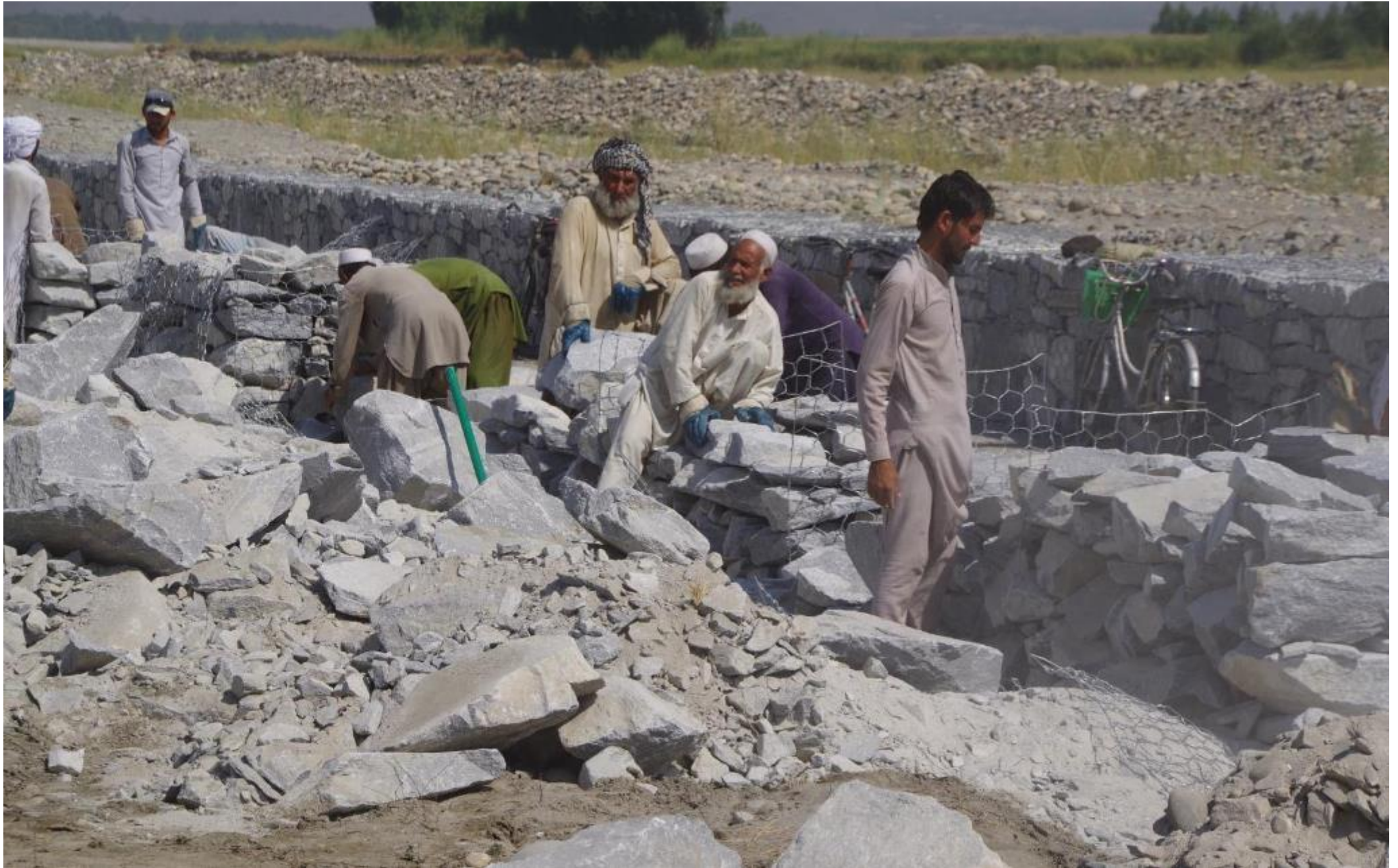
用水路底のライニング作業の後を追いかけるように水路側壁の蛇籠工が進む。2017 年 9 月 26 日
