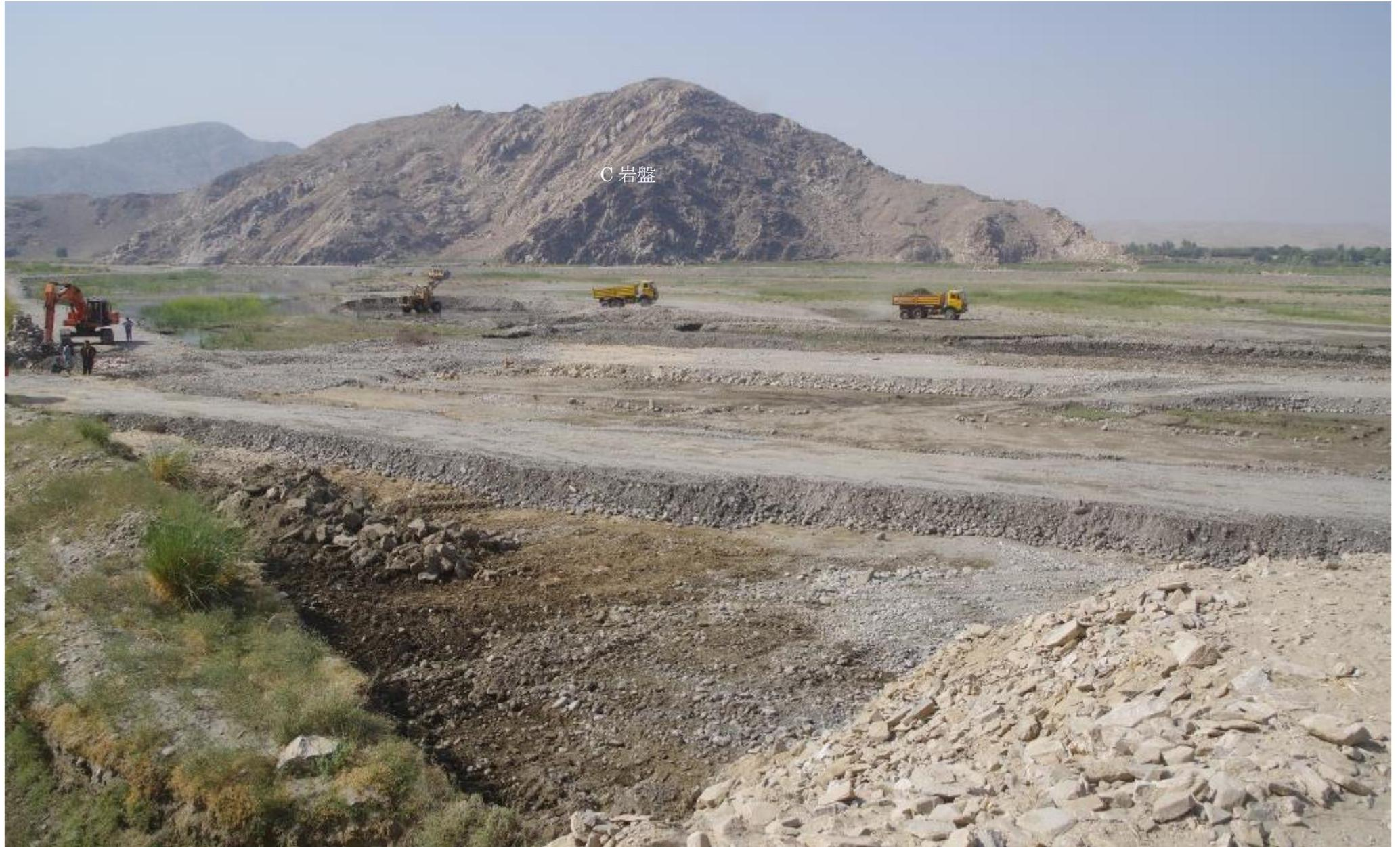
調節池Ⅱの排水門建設風景。今期は構造物建設が集中していて、水路横断橋梁4か所、サイフォン1、送水門2、排水門2が同時に進行している。まもなくタラン分水の基礎が始まり、来週からカマ着工が加われば、記録的なコンクリート仕事となる。冬期でもこのような状態は初めてだ。二チームが疲弊してはカマが進められないので、工夫が要る局面。2017年10月11日
