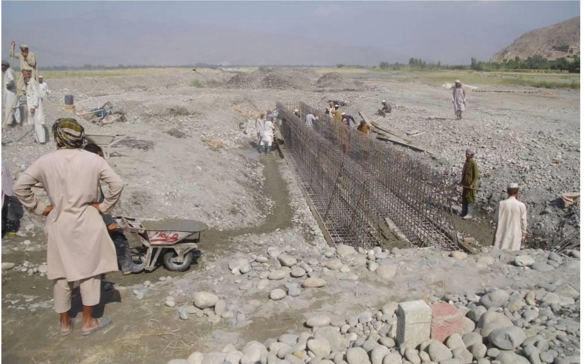
調節池Ⅲの基礎ができ、全体の構図が明らかになってきた。上流（調節池Ⅰ・Ⅱ）の排水管理で湿地帯が後退し、作業がやりやすくなっている。砂利採取が至近距離であることも幸いして、かなりのピッチで仕事が進んでいる。2017年10月11日
