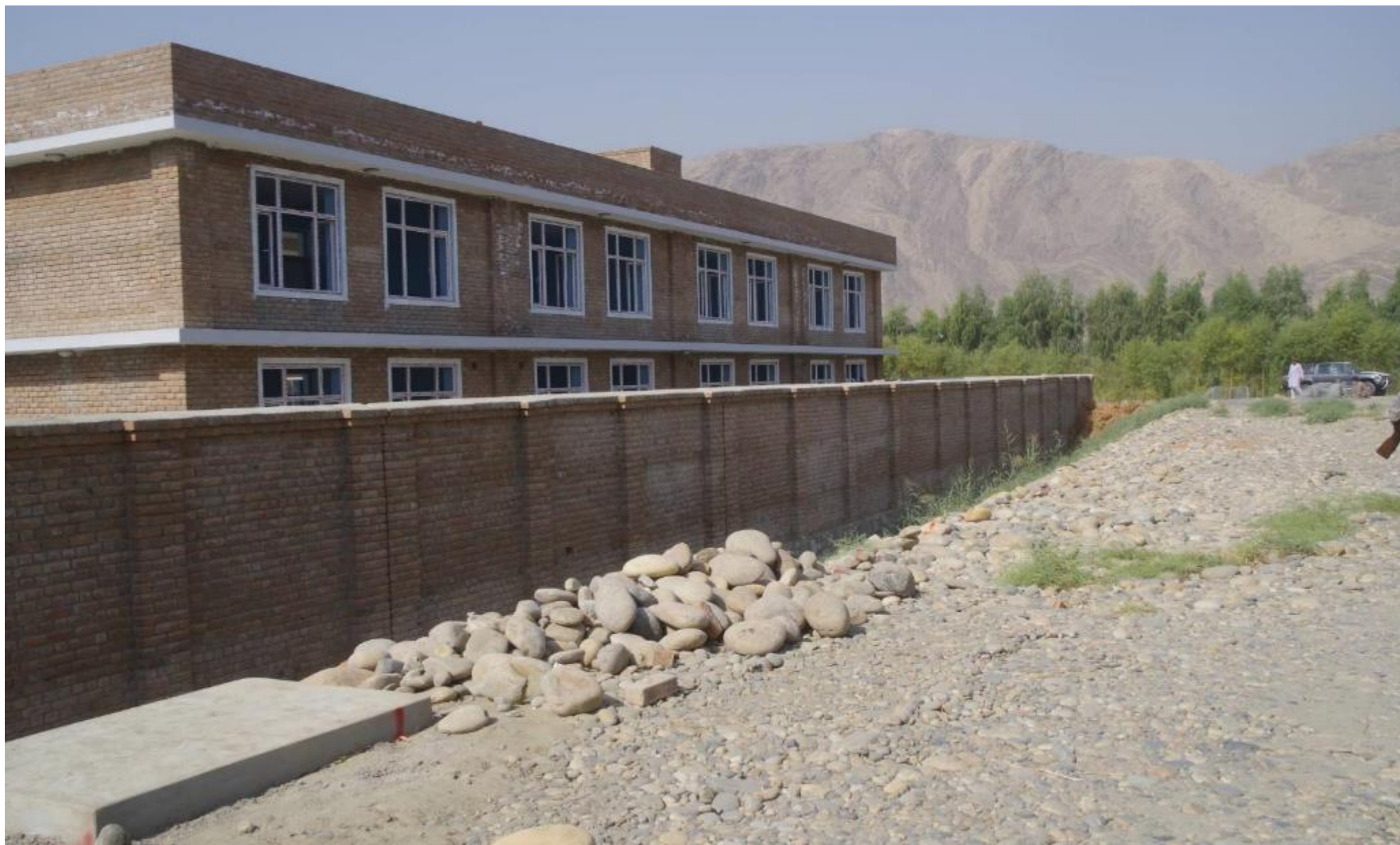
建物を川側から見る。2017 年 10 月 12 日
