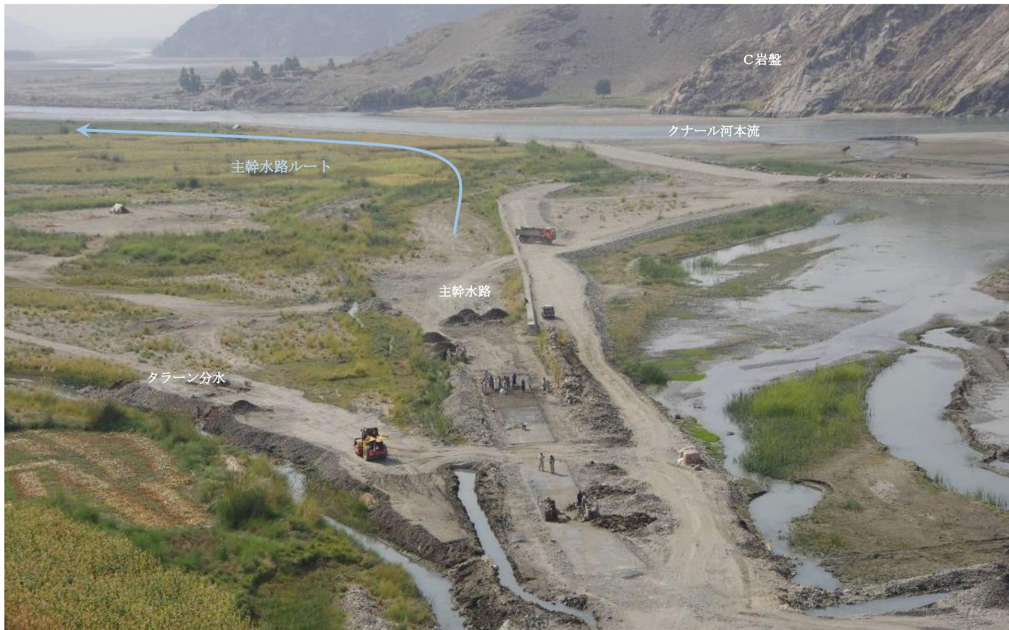
調節池上流側を望む。排水路は一時河側へ導き、サイフォン建設後に元の位置へ戻す。
