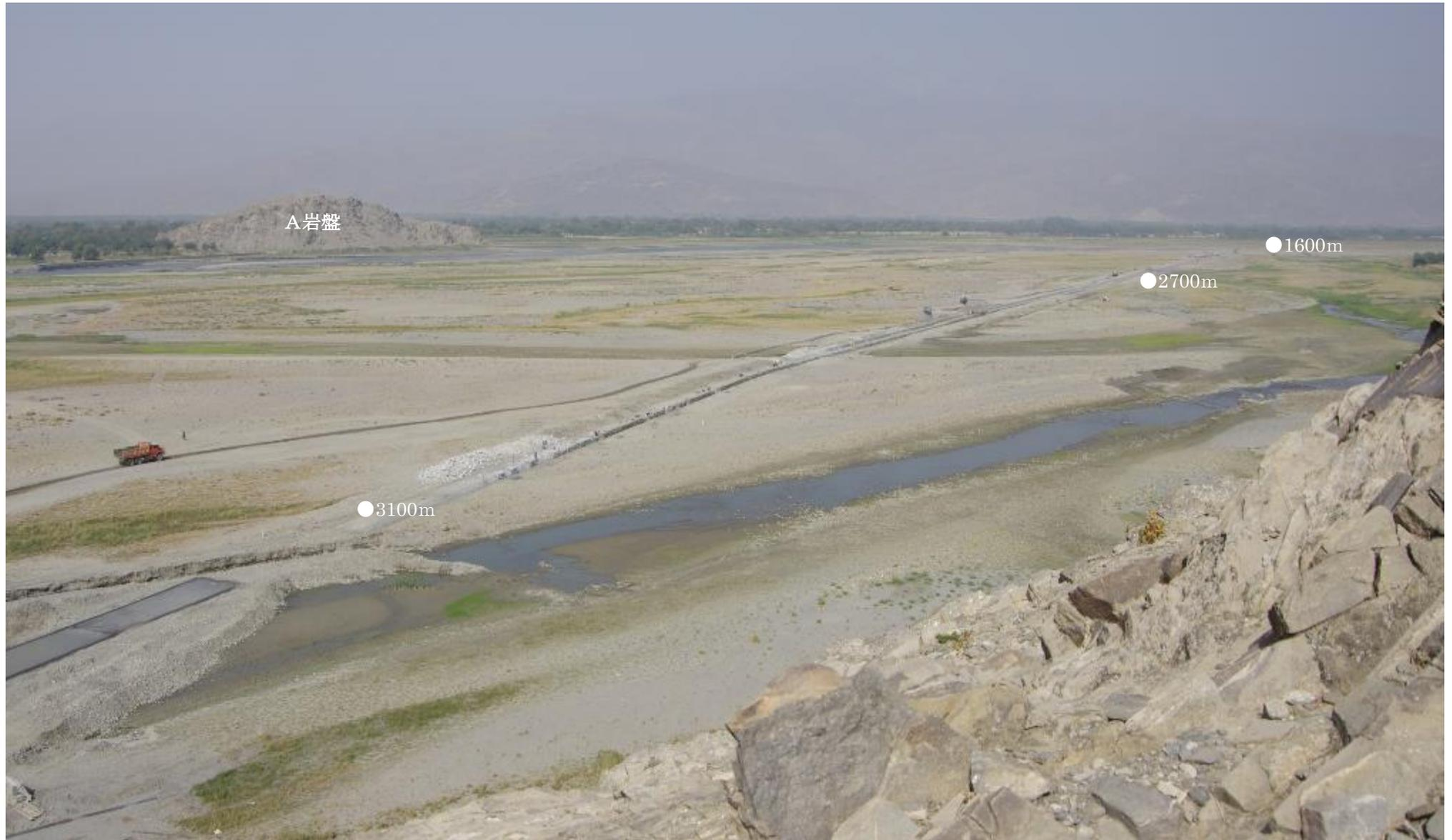
主幹水路ライニング工事の先端。3400m地点。水路幅が狭まった分だけ早い。一日 30mを仕上げる。
