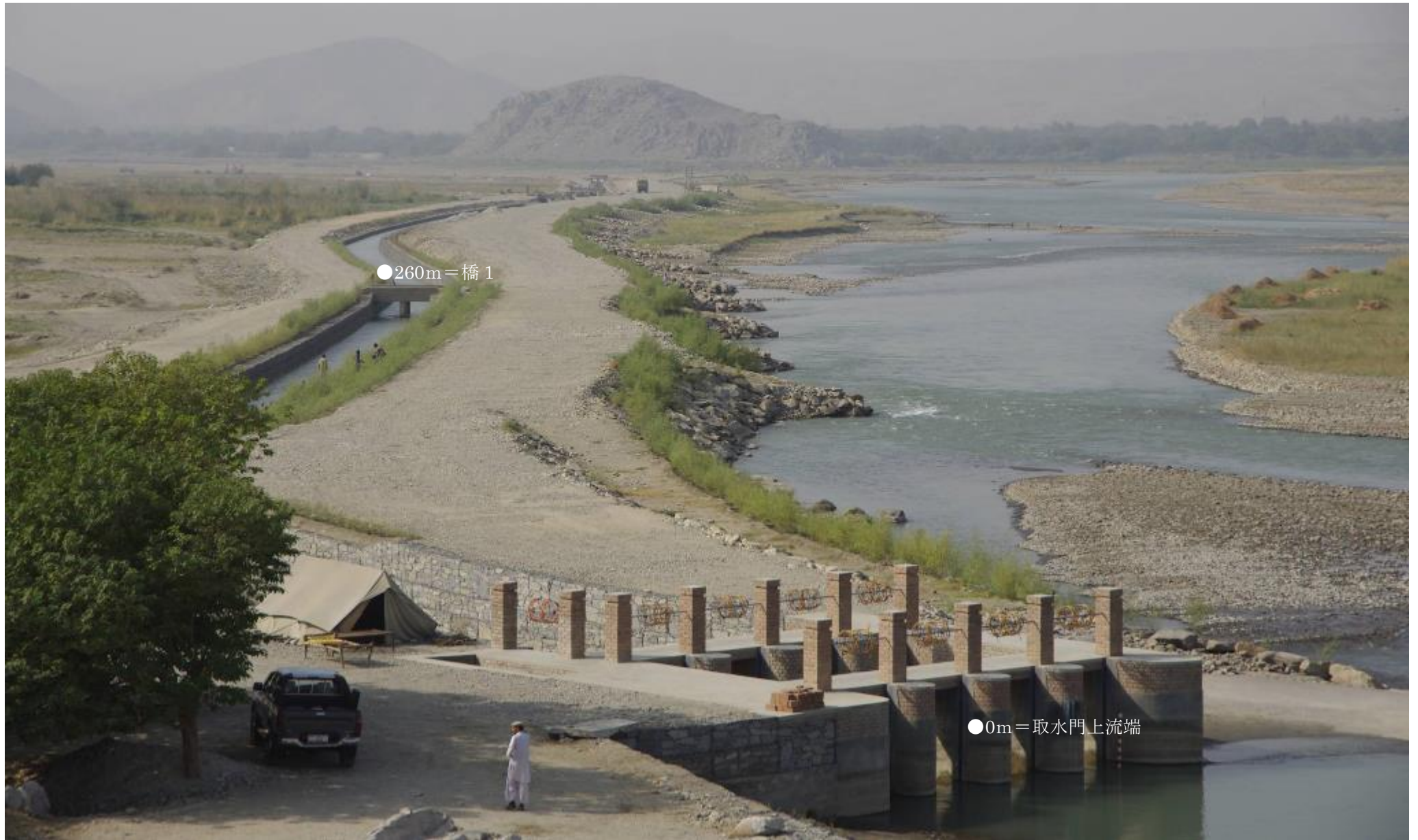
B 1 岩盤から用水路下流を望む。
