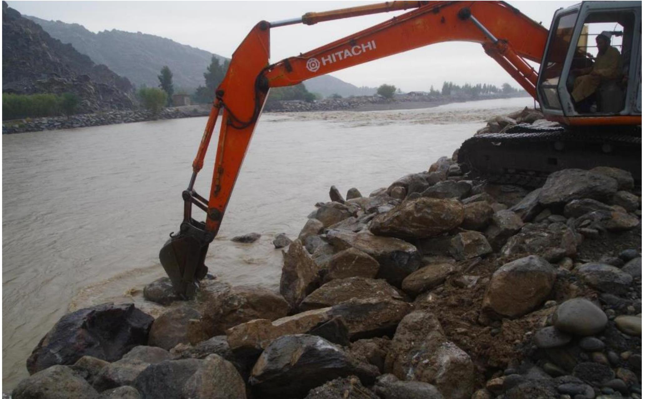
砂州 1 とベスード側の臨時交通路。砂利堆積で浅くなった河道Ⅱを締め切り（約 50m）、砂州上に交通路（約 700m）を敷設、石材輸送を開始している。
