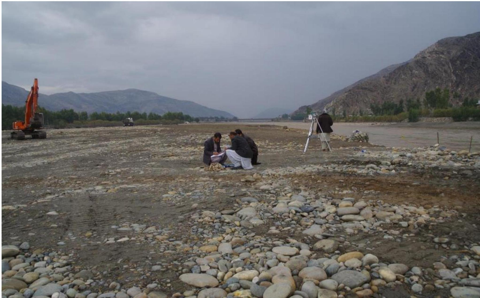
前後の河床材料。粒径 30 cm を超えるものが多い。砂州の表面保護は大切で、堰の前後は必ず大粒径の砂利を厚く敷く。目安になるのがこの程度の径だ。それでも不安があるときは、籠を埋設したり、柳枝工で補ったりする。2017 年 11 月 16 日
