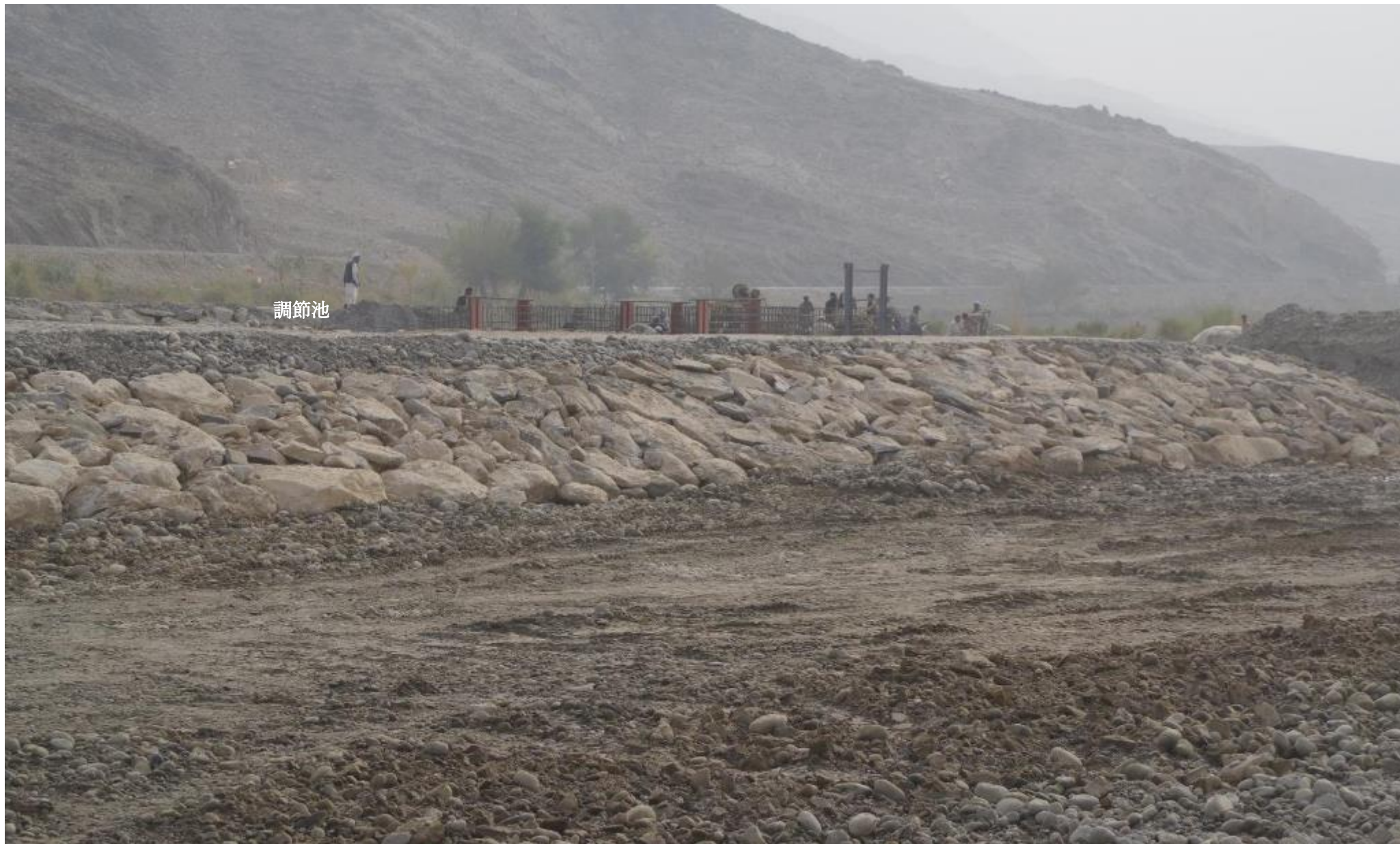
調節池Ⅲの外壁基礎。洪水浸入時に備え、堤防（二重堤防の内側）を兼ねる。2017 年 11 月 14 日
