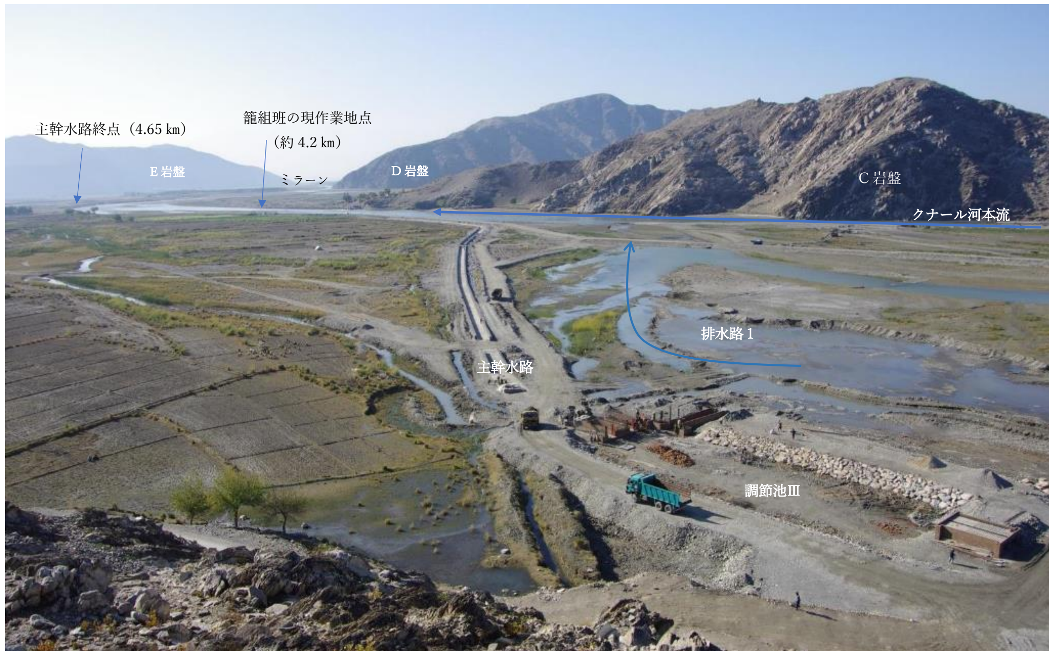
調節池Ⅲの下流側を望む。蛇籠組（水路両壁）グループはライニング班の約 200m に追いついている。2017 年 11 月 20 日
