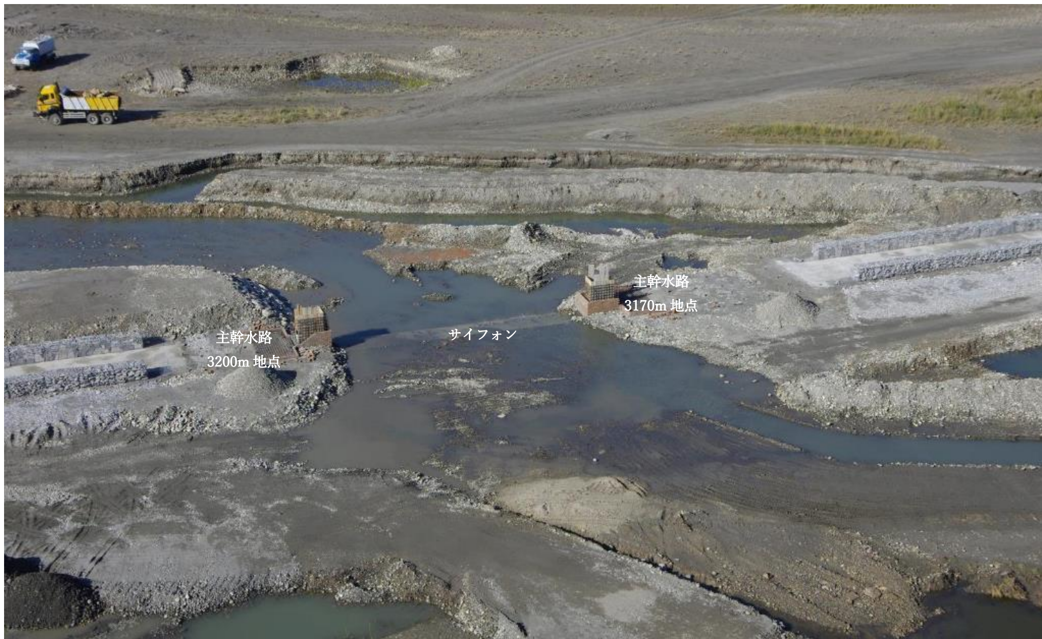
調節池Ⅲの上流側。サイフォンが埋設され、河道（排水路1）を元の位置に戻す作業が進んでいる。2017年11月20日
