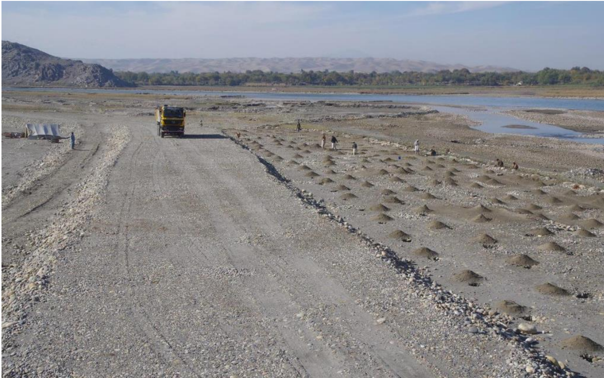
調節池Ⅱの川側に置かれた特別堤防。樹林帯の造成が開始された。2017 年 11 月 23 日
