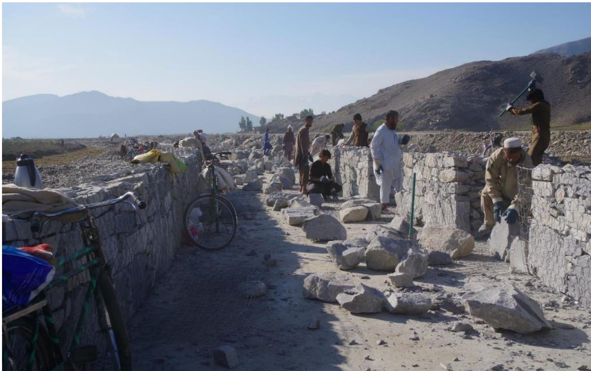
4 km地点を通過中の蛇籠組み作業。2017 年 11 月 23 日
