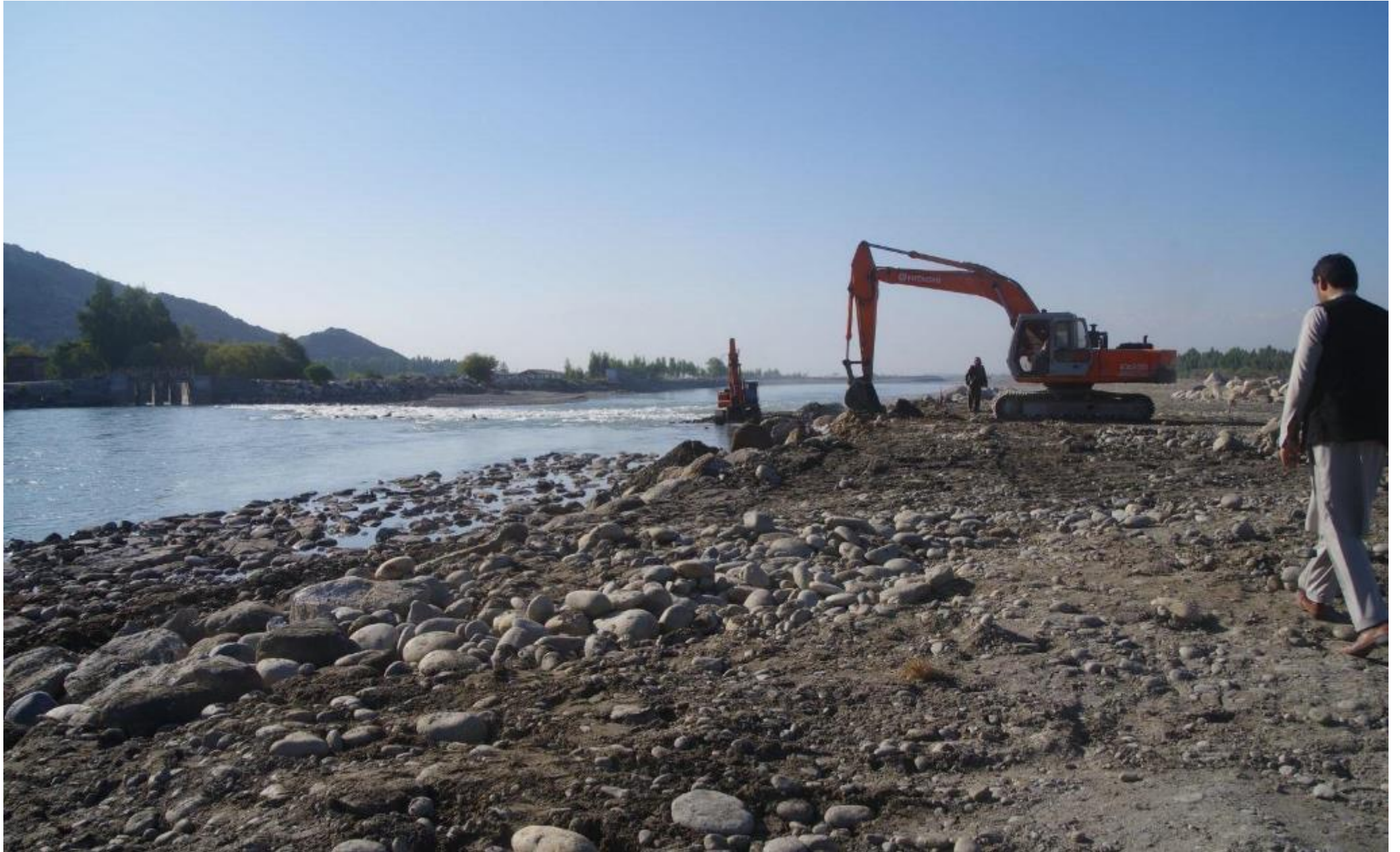
同工事風景。2017 年 11 月 23 日
