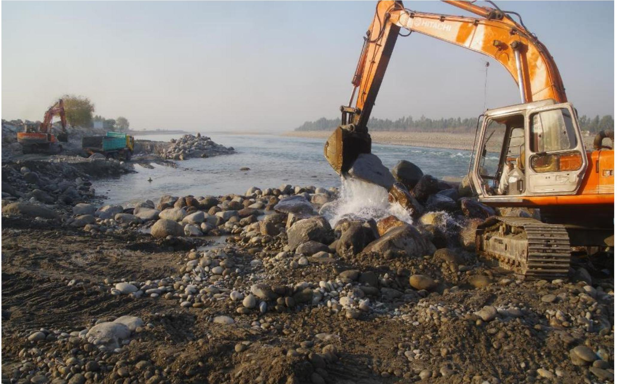
水門側壁の撤去。籠は二列で、外側の空石積み部分に変形、内側の列は背面のソイルセメントで練石積みのようになっていて、殆ど崩れはなかった。外側の列を撤去、内側列をモールドに見立て、厚い鉄筋コンクリート壁を造成する。2017年12月11日
