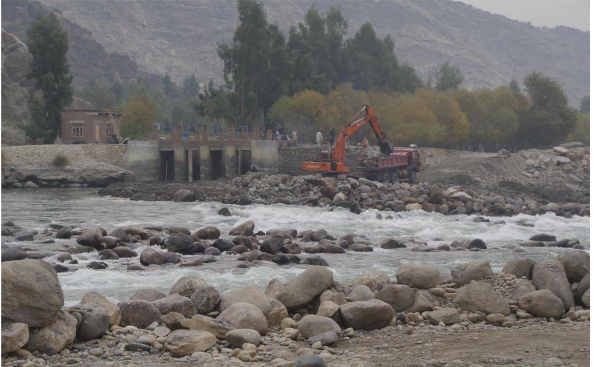
石堰の良いのは、巨礫を再利用できることだ。撤去した石は溜めておき、堰再建に使う。ただし量が膨大で、皆が改めて驚く。カマ第二堰だけでダンプカー約2500台分の巨礫が使われている。斜め堰が鉄筋コンクリートより物量が少ない訳ではない。2017年12月10日
