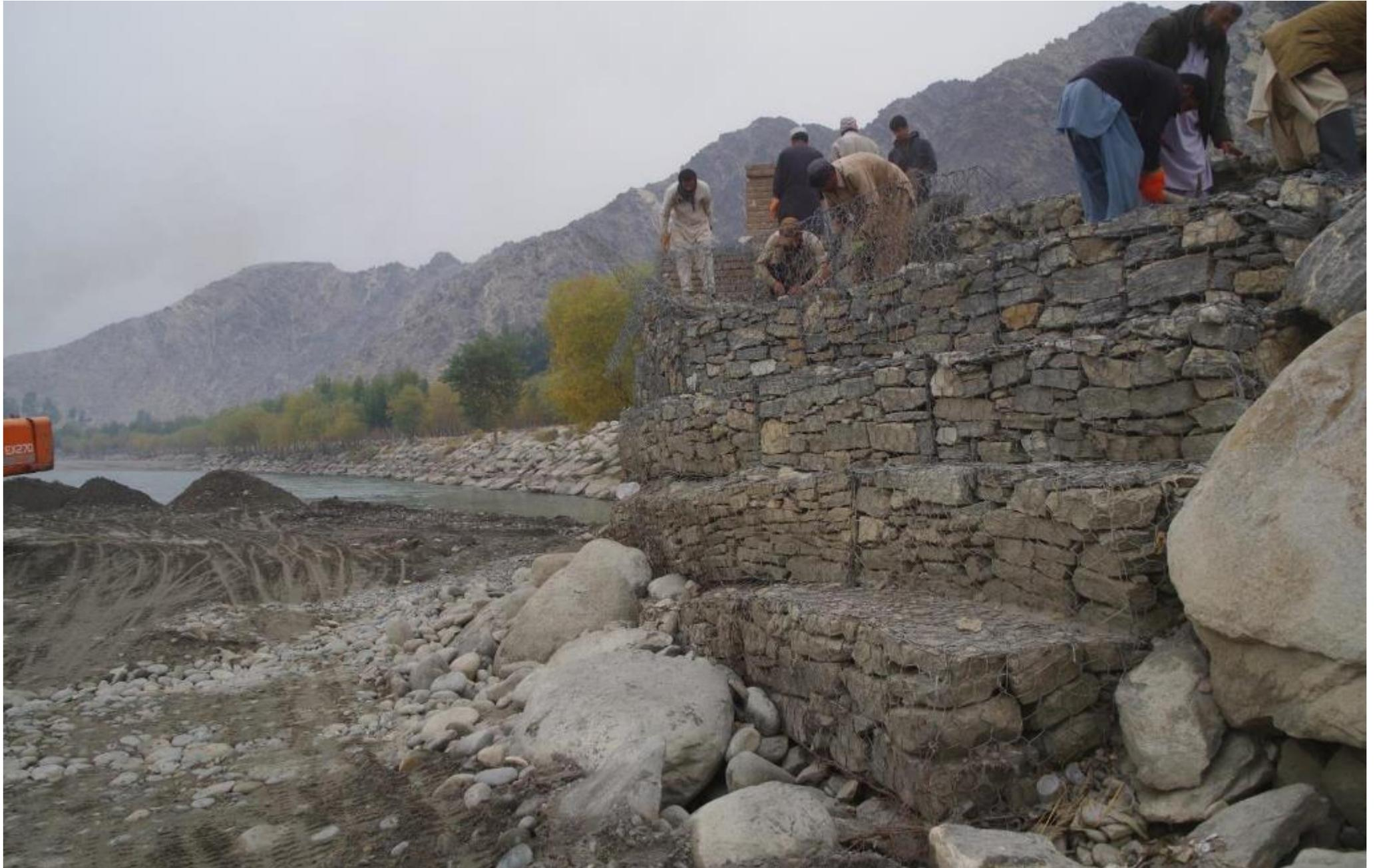
堰造成のための最終測量と標識の設置。GPS は誤差が大きく、結局川に綱を渡して実測するのが早道だった。理由はよく分からない。整然たる紙の記録より、作業員が大声で伝える実測値を信ずる。2017年12月11日
