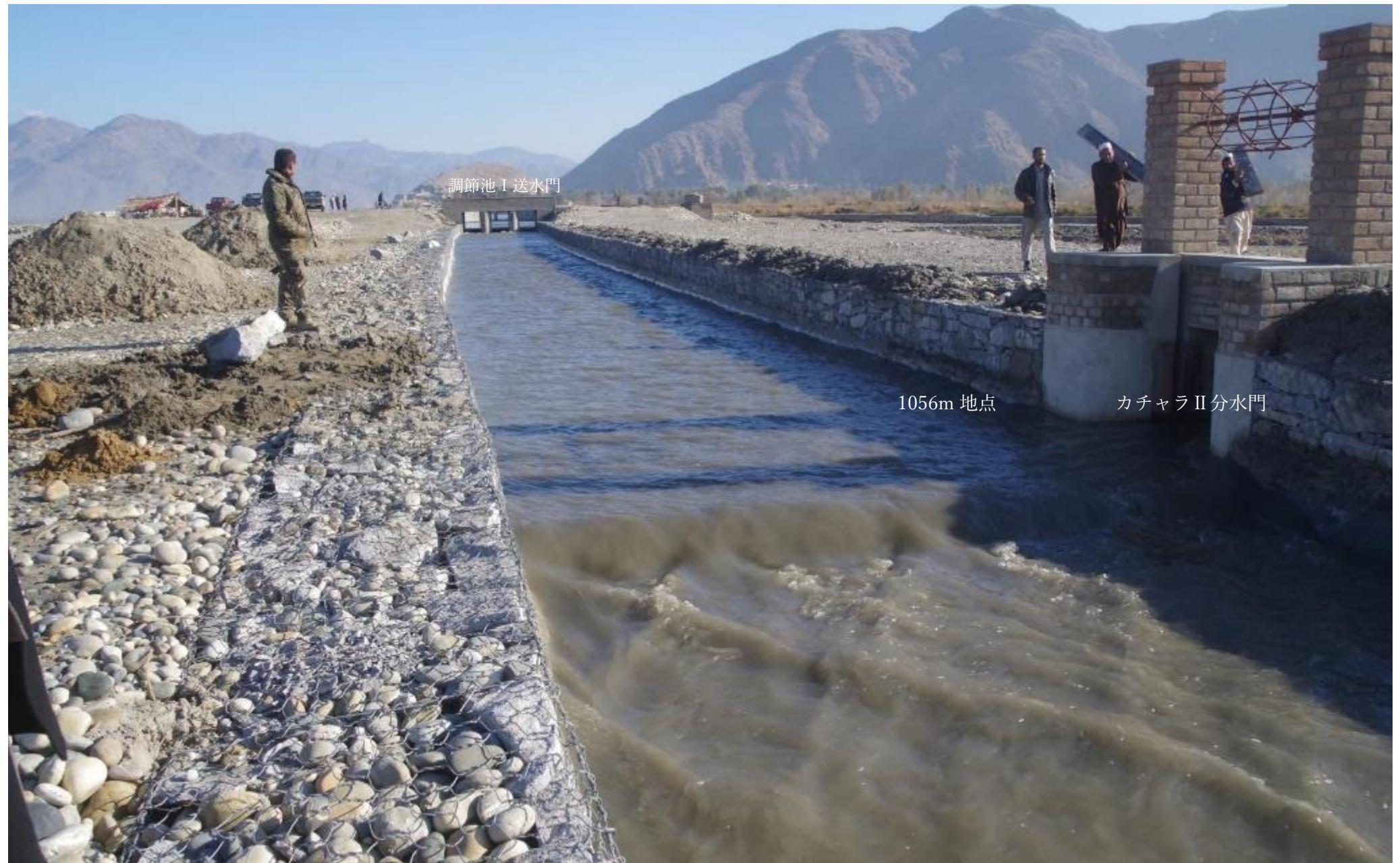
調節池IIと橋3（1471–1481m 地点）を下流側から見る。初めての送水なので、水路内の泥が洗い流され、濁流に見える。
