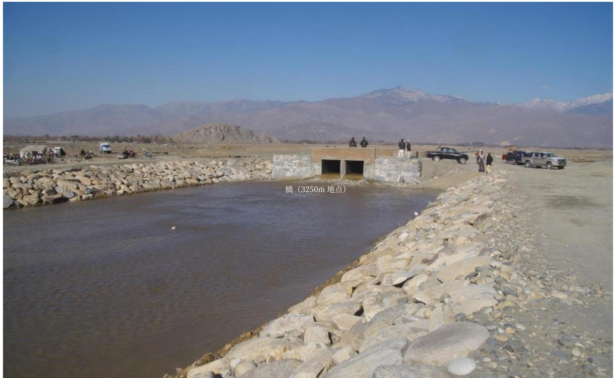
サイフォン。排水路の水は調節池 I と II で調整されていて普段は少ない。夏季の山沿いで発生する鉄砲水の流路となる。サイフォンカマ場間の距離は 20m、周囲の石垣はまだ高くなり、下流側は調節池IIIの外壁堤防と連続される。
