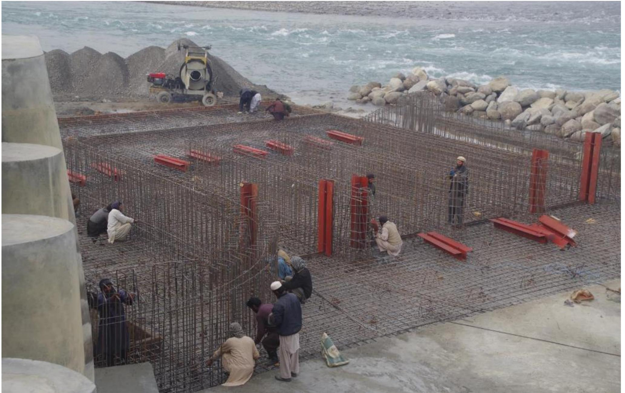
水門下部および隣接堤防の基礎は、12月25日までに完全に終了した。写真は12月25日
