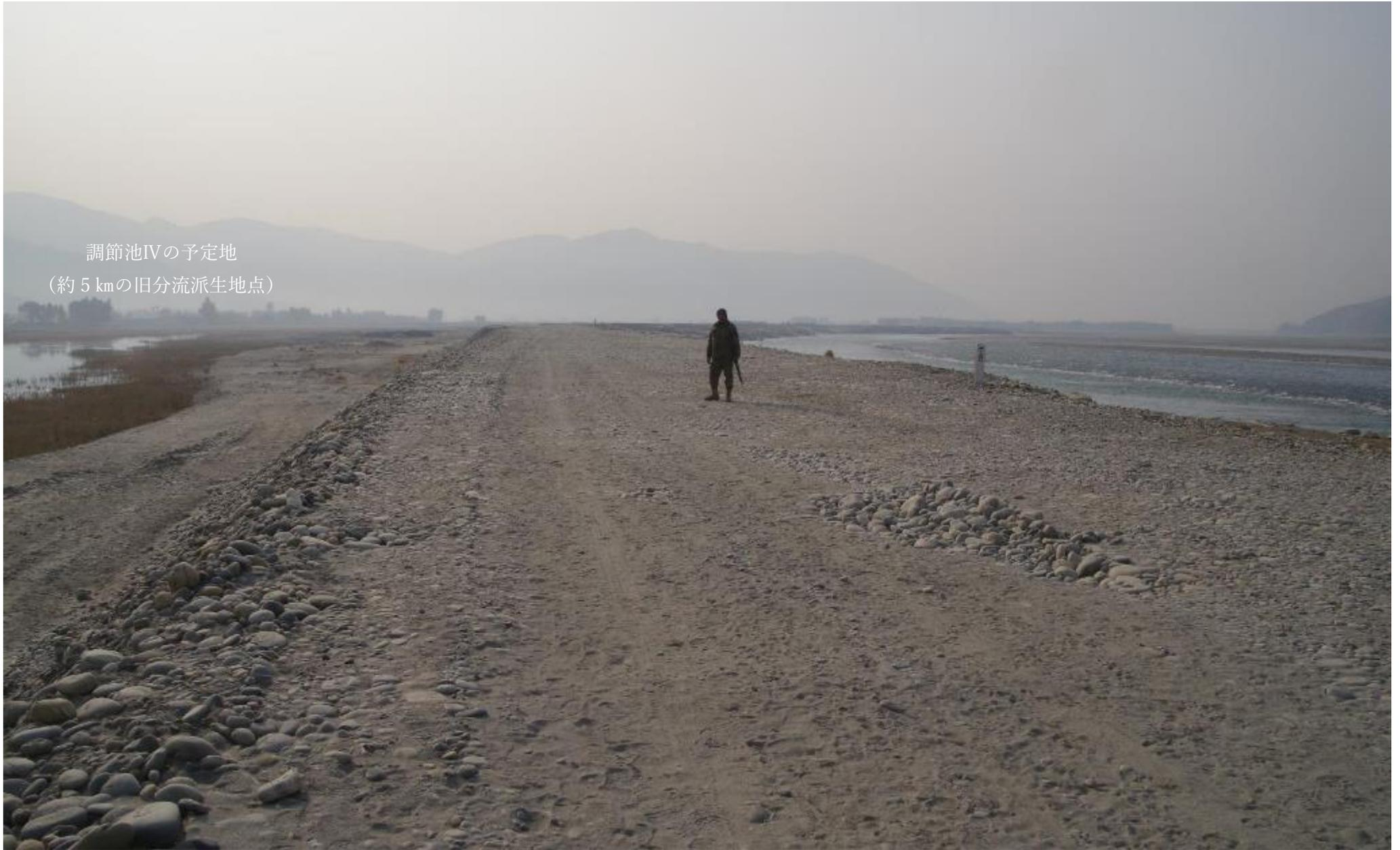
同川側の状態。河道の外縁に当たり、流速が早く、浸食が進んでいた。50m 毎に水制を設置、水制間の土砂堆積を促して根固め工の代用とした。二回の増水期を経て、河床が著しく低下し、溢水の危険は遠のいている。現在安定しているが、第二期工事で更に完璧を期す。2018年1月24日
