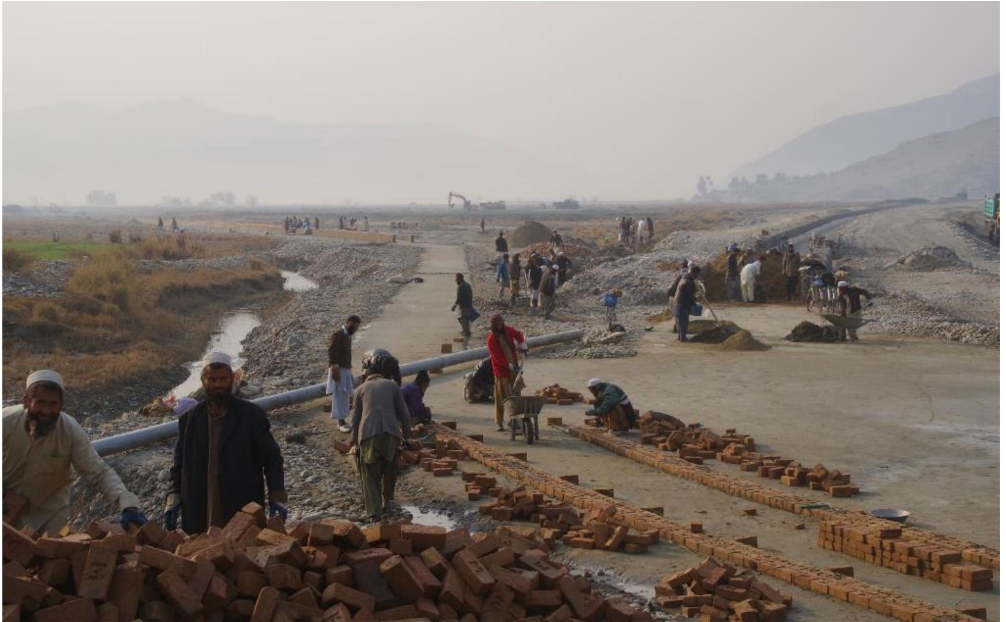
分水路はソイルセメント・ライニングの上にレンガ壁を積んで作る。傾斜が急なので、毎秒  $1.0 \text{ m}^3$  は優に流せる。2018年1月24日
