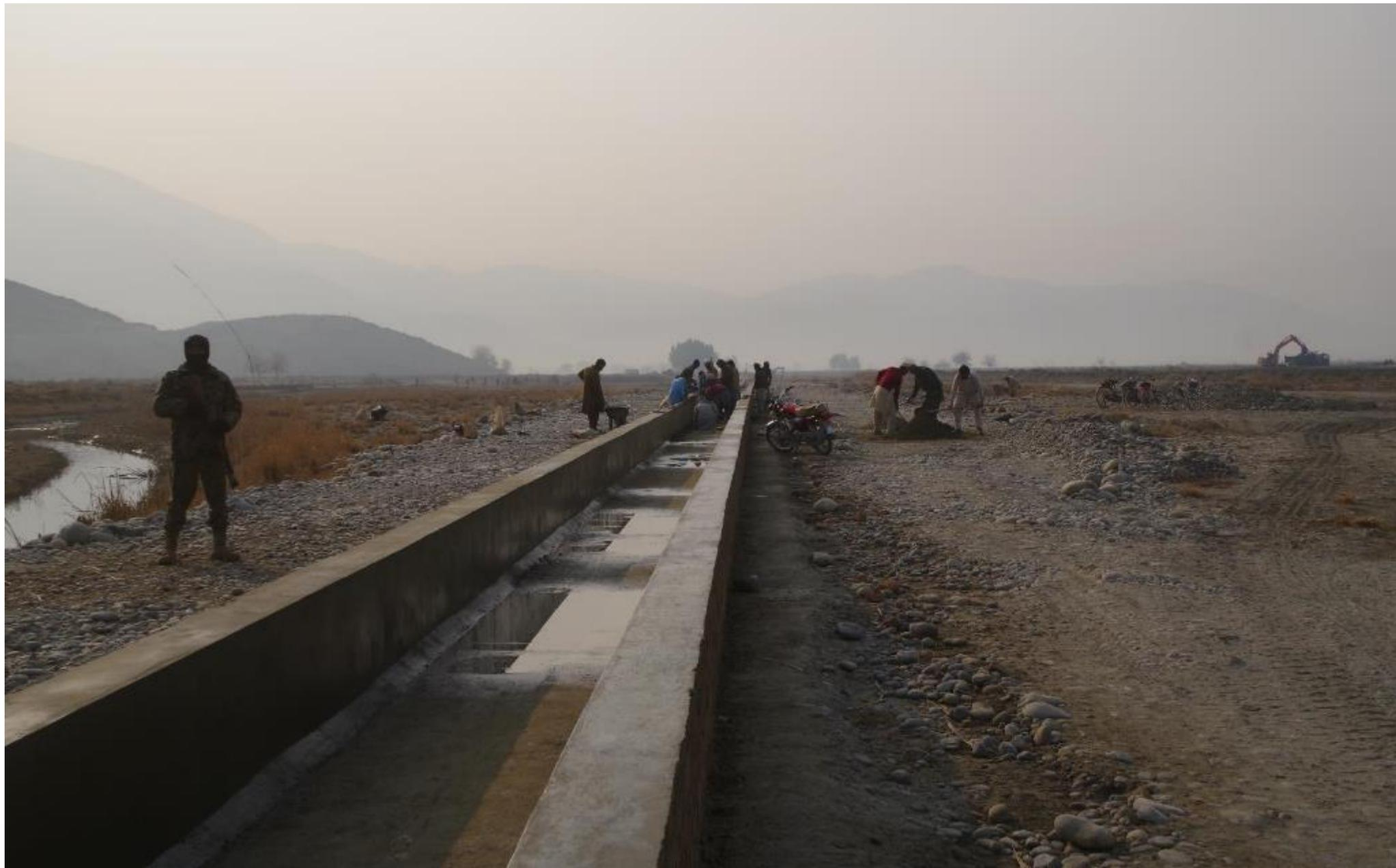
調節池IVに到着した主幹水路。川側堤防は幅約 15m 前後で、更に高くされる。最後の橋 9 の建設中。2018 年 1 月 24 日
