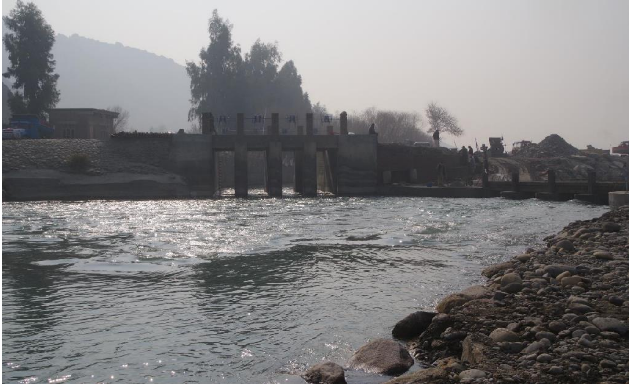
カマ第二堰取水門を工事中の堰から見る。2018 年 1 月 25 日
