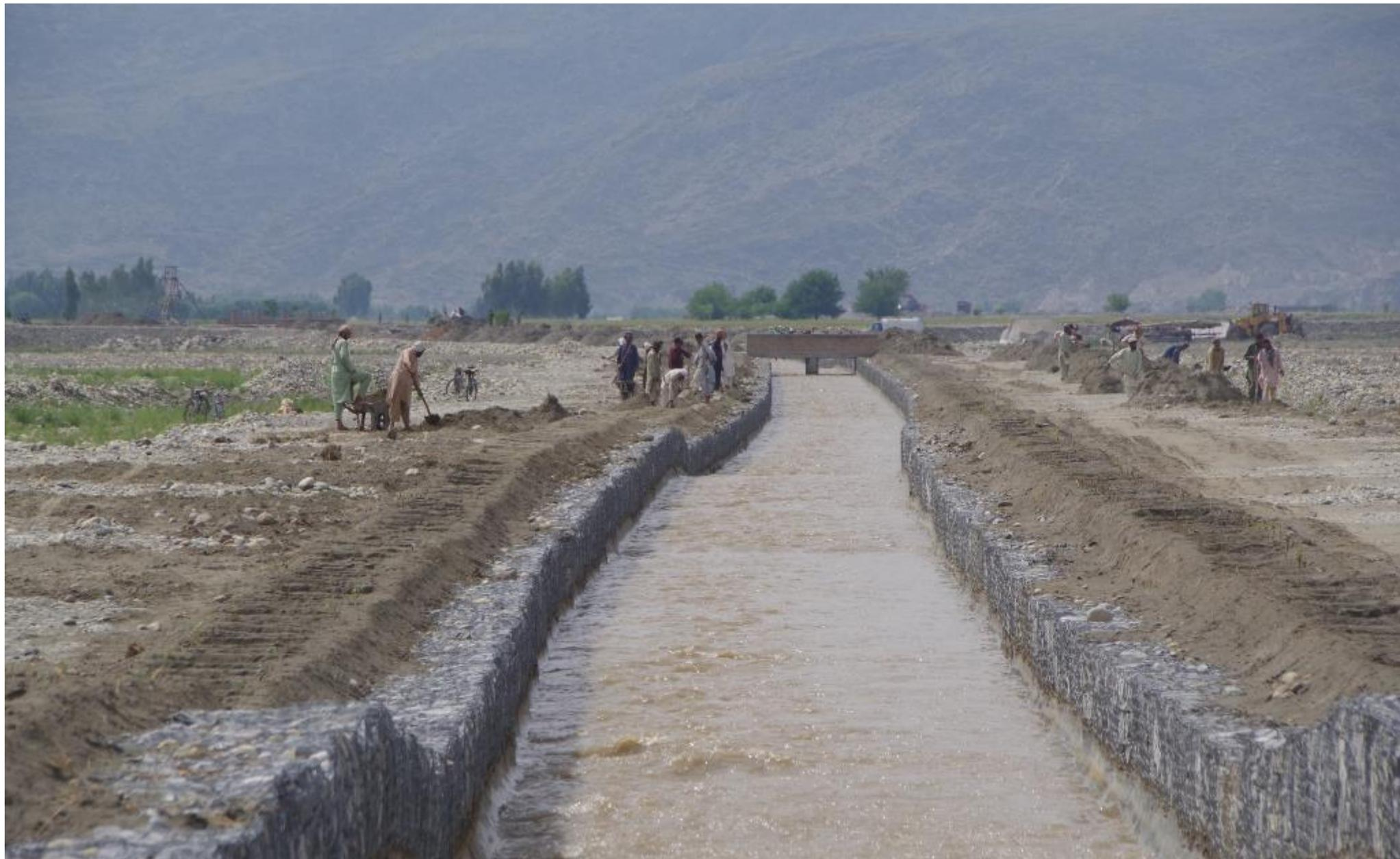
調節池Ⅳの現在。詰めの確認測量を終え、ベラ延長路と同時に進められている。作業地の分散を避けるため、植樹班を除く全員が集中する。池底は約 1.5m 底上げし、送水口（橋）と排水門の建設が始まった。ベラ延長路も基礎を十分に強化して工事が進行中。2018 年 4 月 22 日
