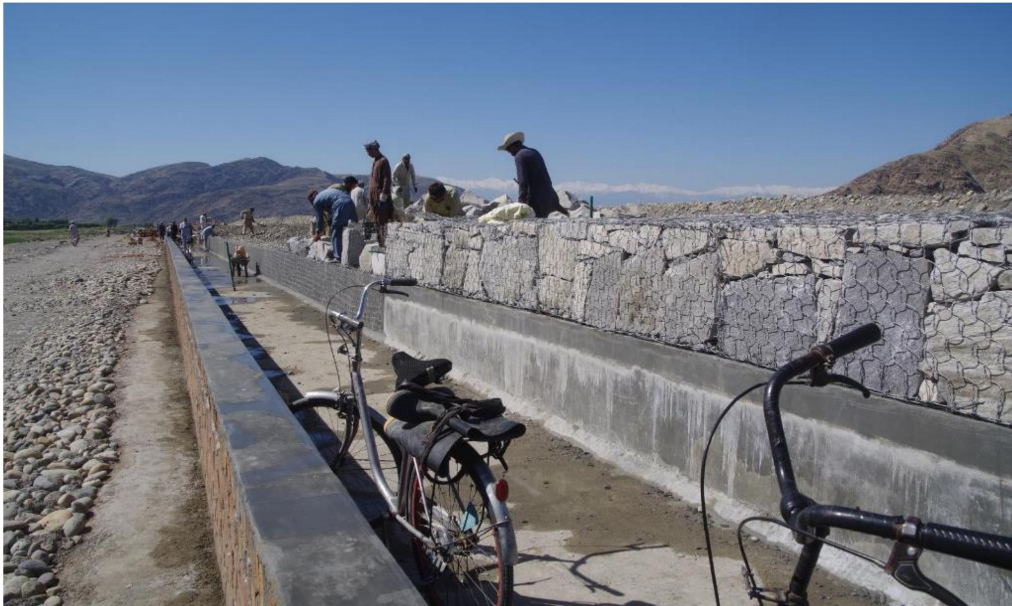
現堤防の最下流端の6 km地点。住民が作った取水口の残骸がある。木や砂利で作って取水していたが、このような場所から洪水が侵入、年々河岸線が後退していた。ベラ延長路が来れば不要になるが、これはこれで人々の命をつないできたのだから、皆が評するように悪しざまに言う気にはなれない。ひどい被害は、むしろ援助の手が入った後で、力づくで作った取水口だったからだ。2018年4月22日
