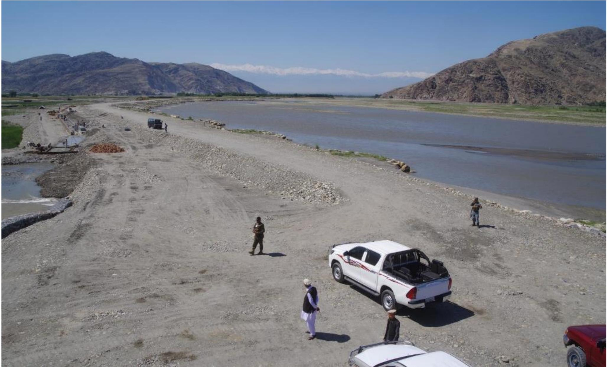
シギ延長路の建設。堤防犬走りに相当する部分を拡張、コンクリート基礎を置き、小水路を建設。堤防素材はすべて粒径の比較的大きな砂利で、土は使われていない。緩速载荷に割く時間の節約ではなく、シルトを混入させると高水時に堤体の軟化、急流による吸出しが起きやすくなるためだ。旧分流自身がドレーン工の役目を果たす。2018年4月22日
