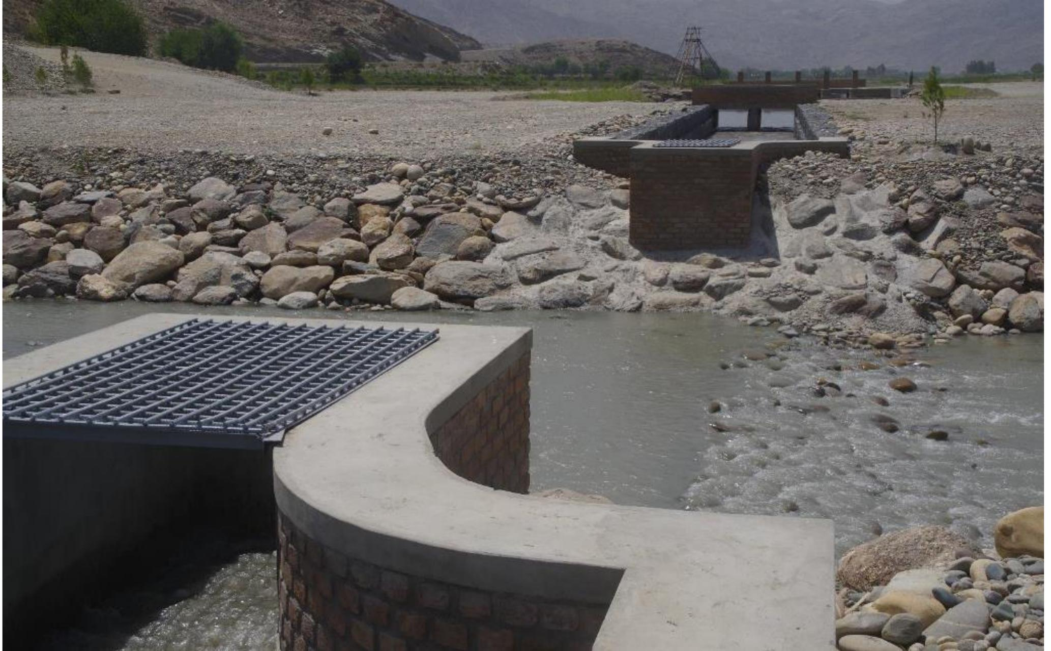
調節池IVを監視塔から望む。全て盛土の上で造作されたので、池としては最も難工事であった。2018年7月1日
