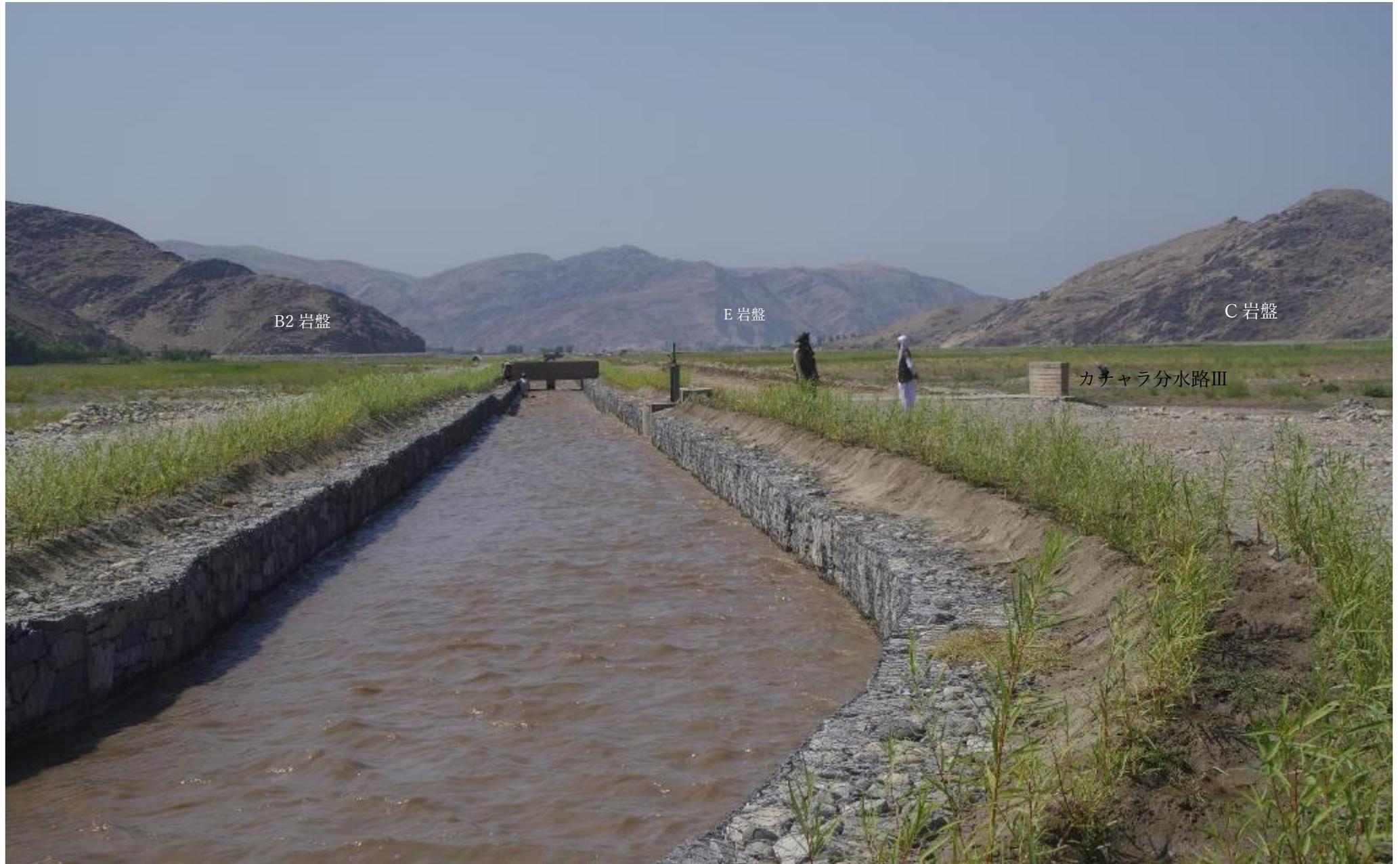
調節池II近傍の強化堤防（Green Mound）。川側の斜面は巨礫が広く埋設してある。作りは調節池IVの前の強化堤防とほぼ同じ。2018年7月1日
