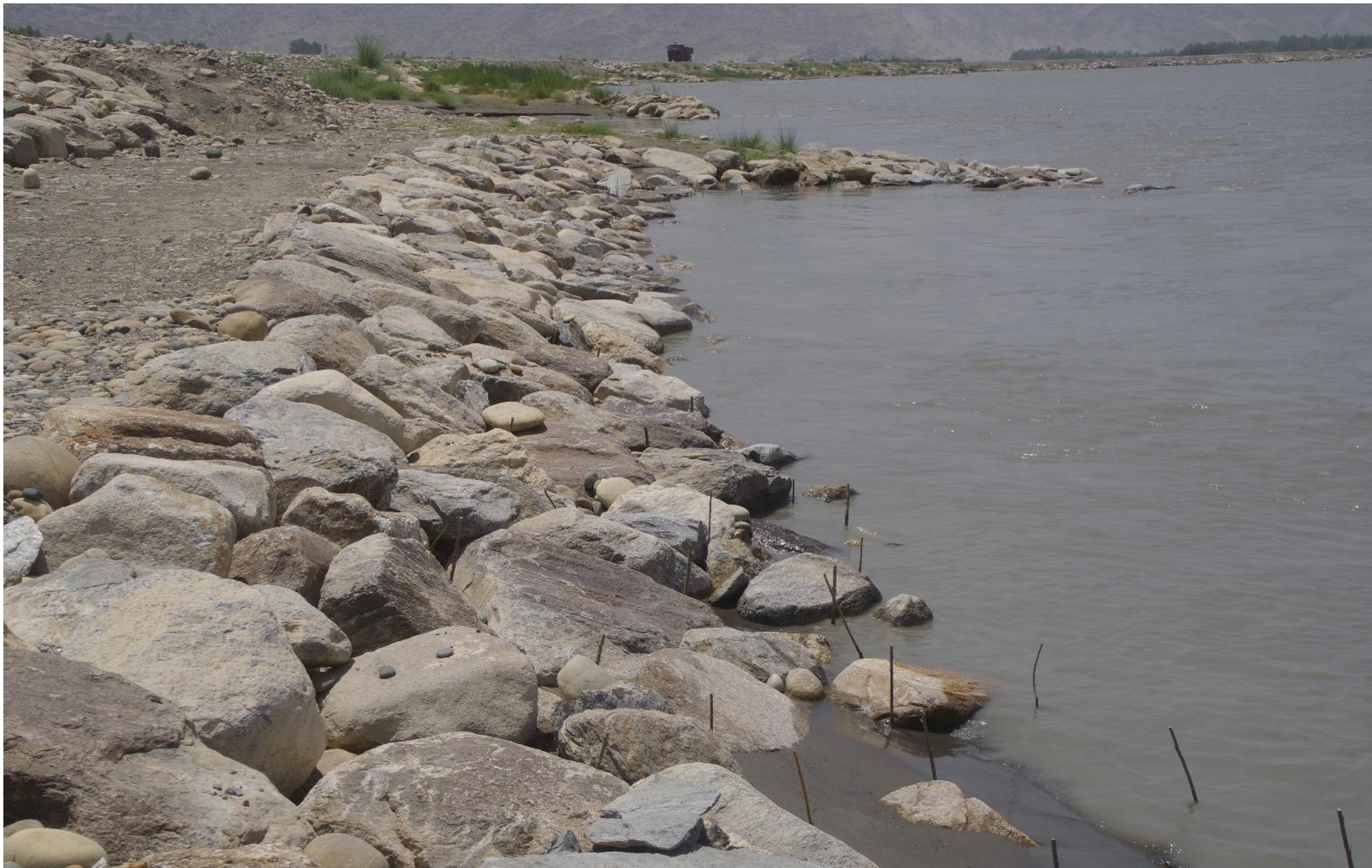
強化堤防（4.8 km地点）川側の柳枝工。挿し木後約 1 週間。2018 年 7 月 11 日
